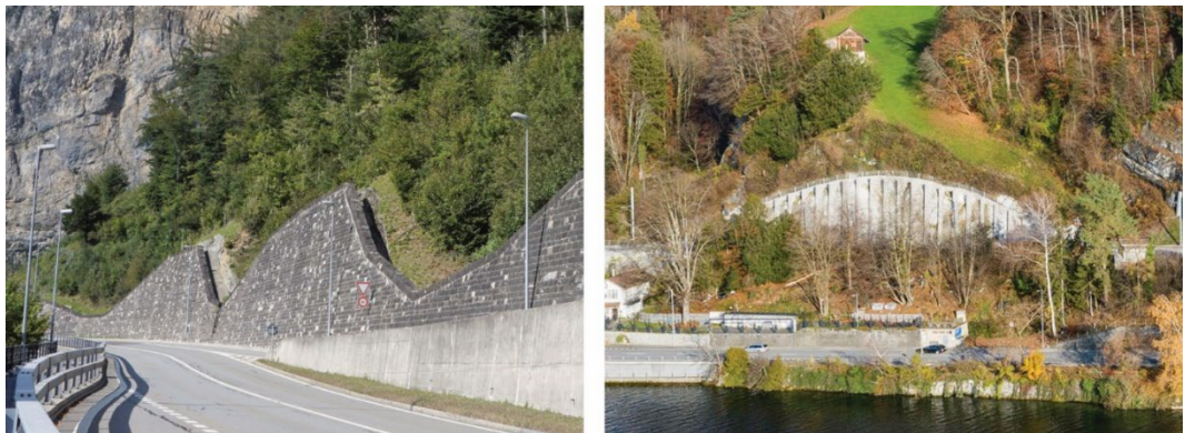
Ill. 27 Peaufinage délibéré du couronnement d'un mur
