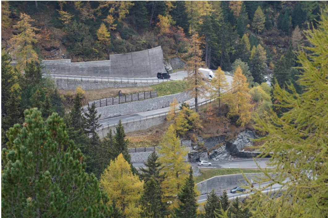
Ill. 53 Ouvrages incohérents sur la route du col de la Maloja
