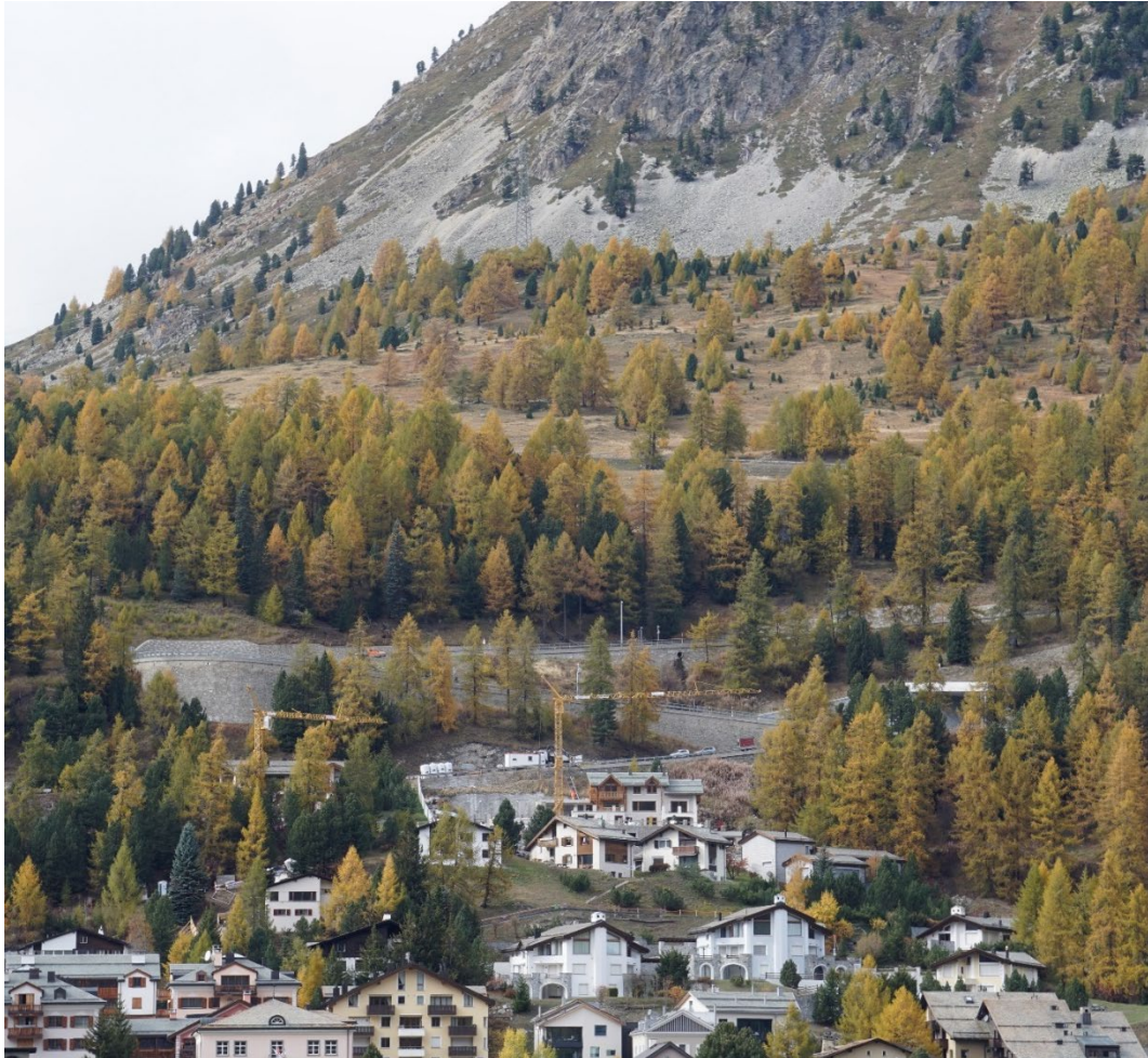
Ill. 57 Jalonnement du tracé de la route par les murs de soutènement
