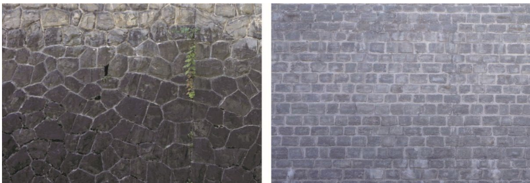
III. 11 Disposition des joints de différents appareils
