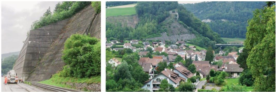
Ill. 41 Faible visibilité malgré la hauteur imposante de l'ouvrage
