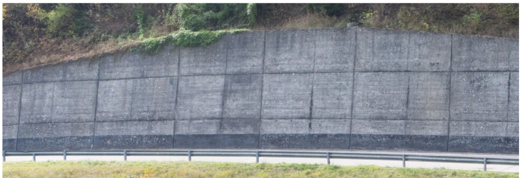
III. 6 Disposition des joints et texture du coffrage
