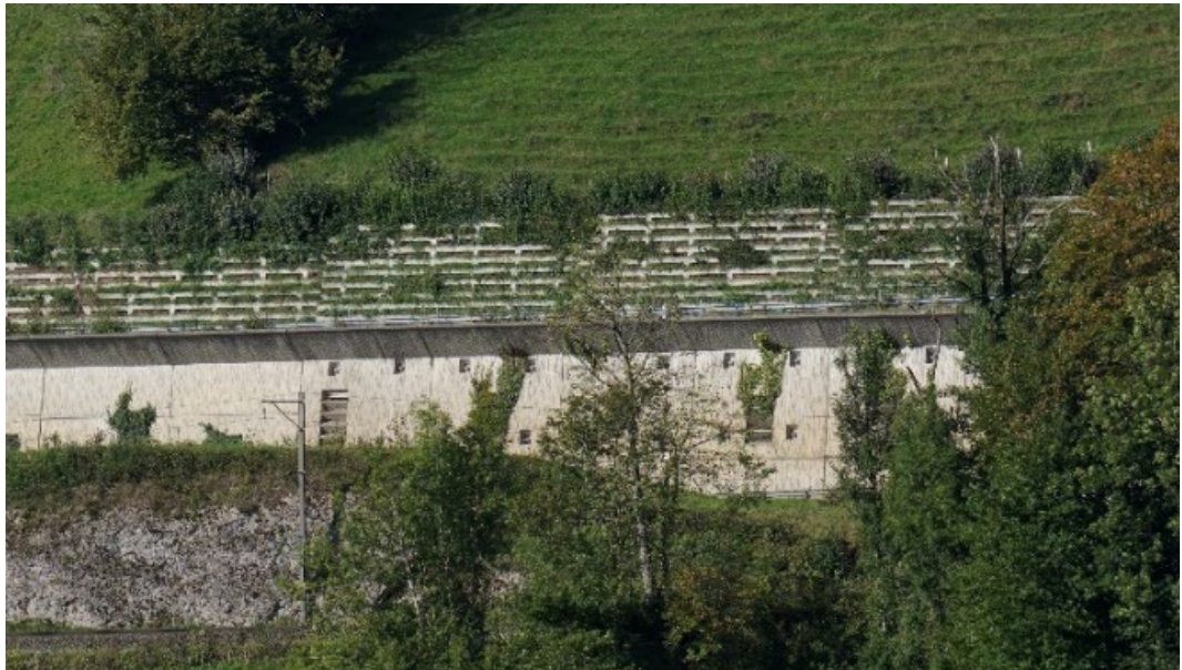
III. 46 Mur en caissons et mur en béton - T16 près de Wattwil
