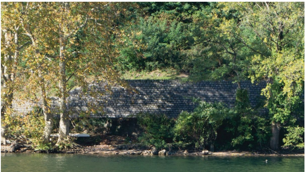
III. 49 Mur en pierres naturelles à l'ombre des arbres
