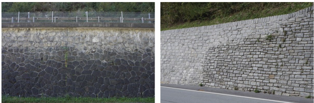
III. 14 Formation d'une patine sur des murs en pierres naturelles
