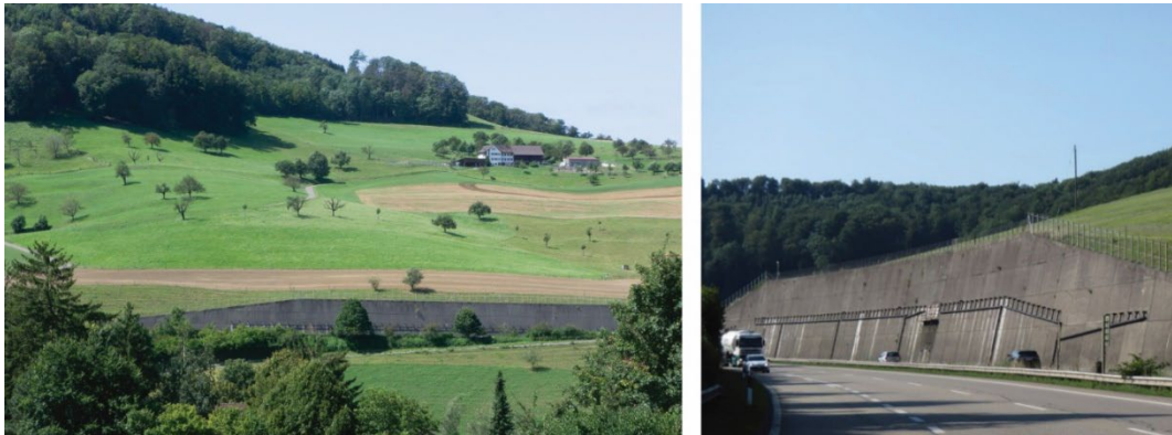
Ill. 39 Mur de soutènement dans un paysage peu bâti
