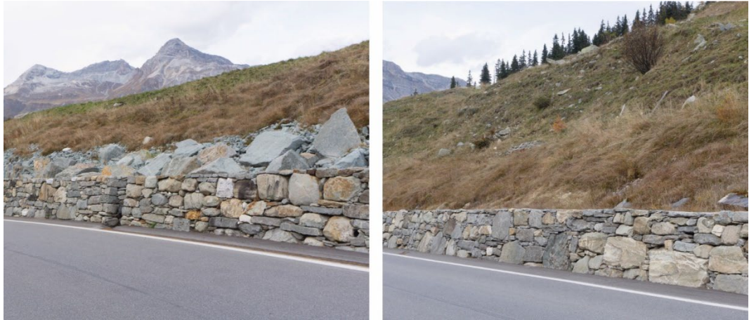
Ill. 26 Arrière-plan d'un mur en pierres sèches
