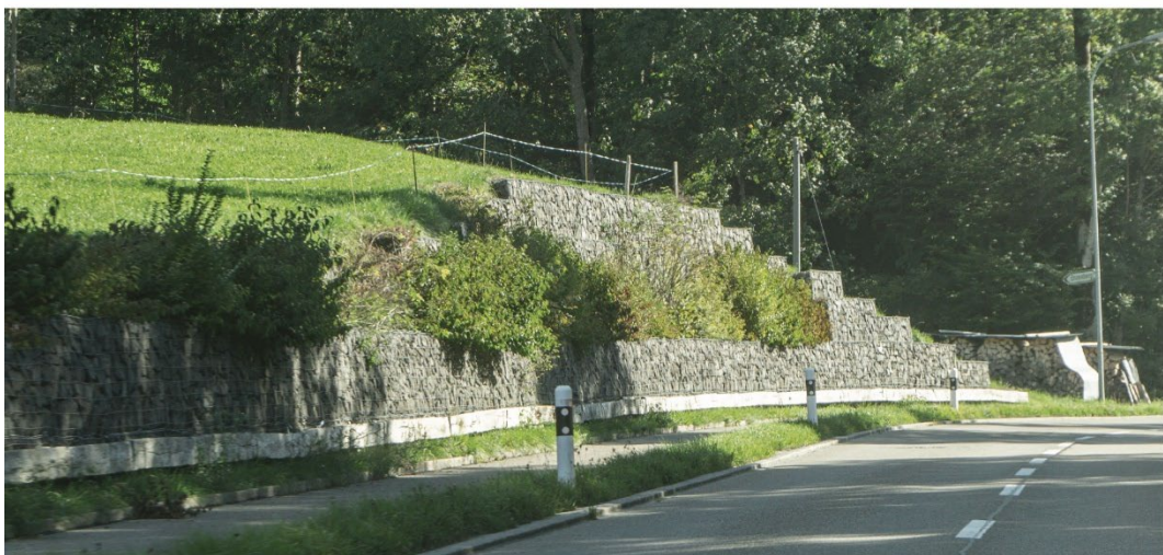
Ill. 15 Contours d'ouvrages avec des gabions
