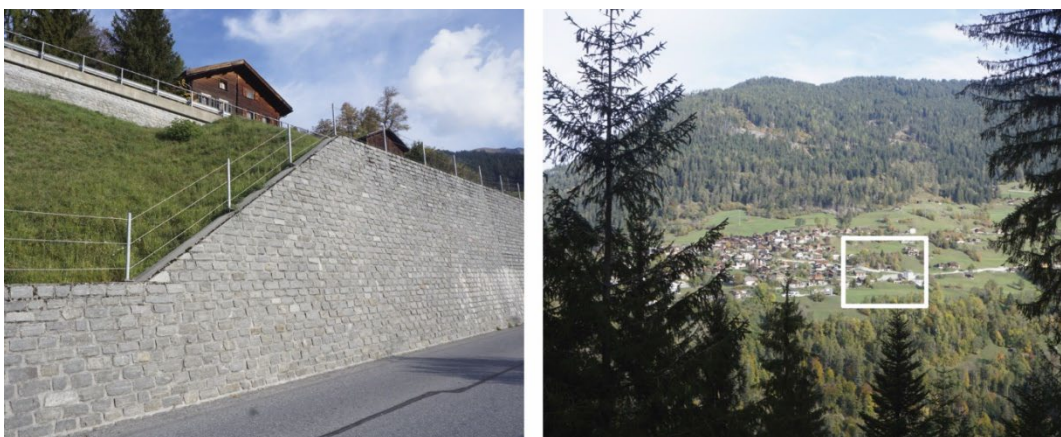
Ill. 40 Mur de soutènement en périphérie d'une ville
