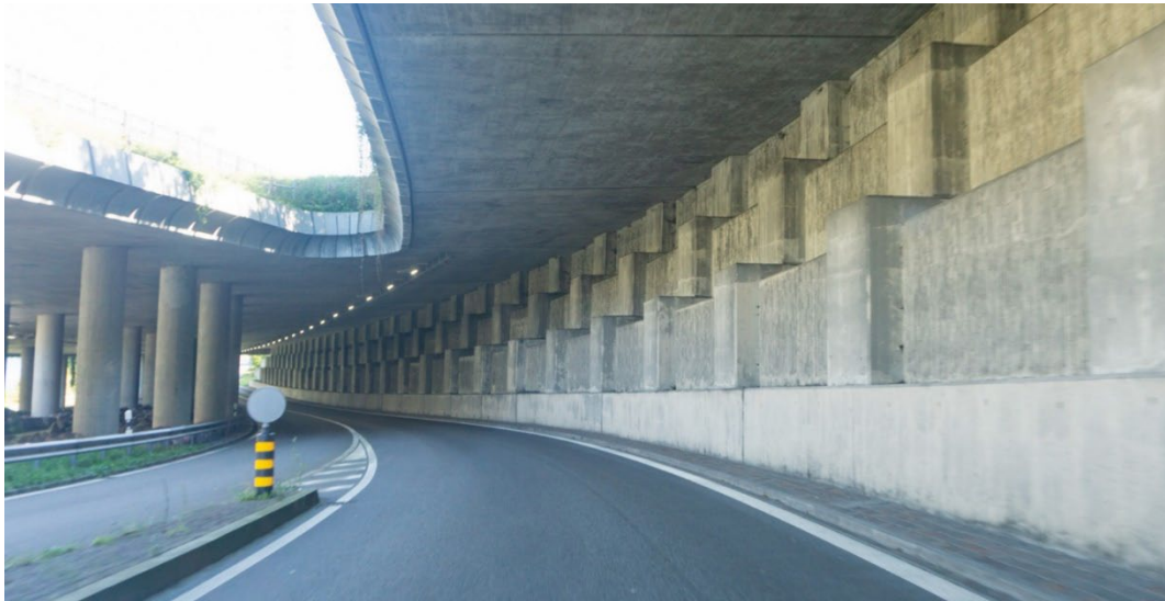
Ill. 7 Esthétique explicite d'un ouvrage en béton
