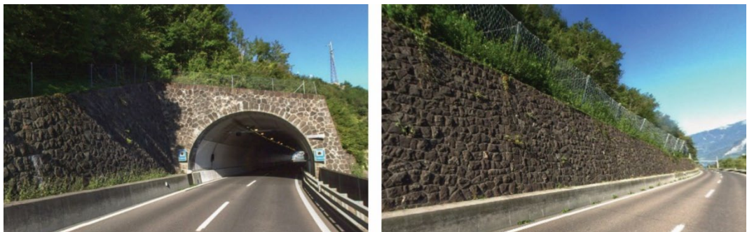
Ill. 52 Aménagement uniforme des ouvrages d'art sur la N3
