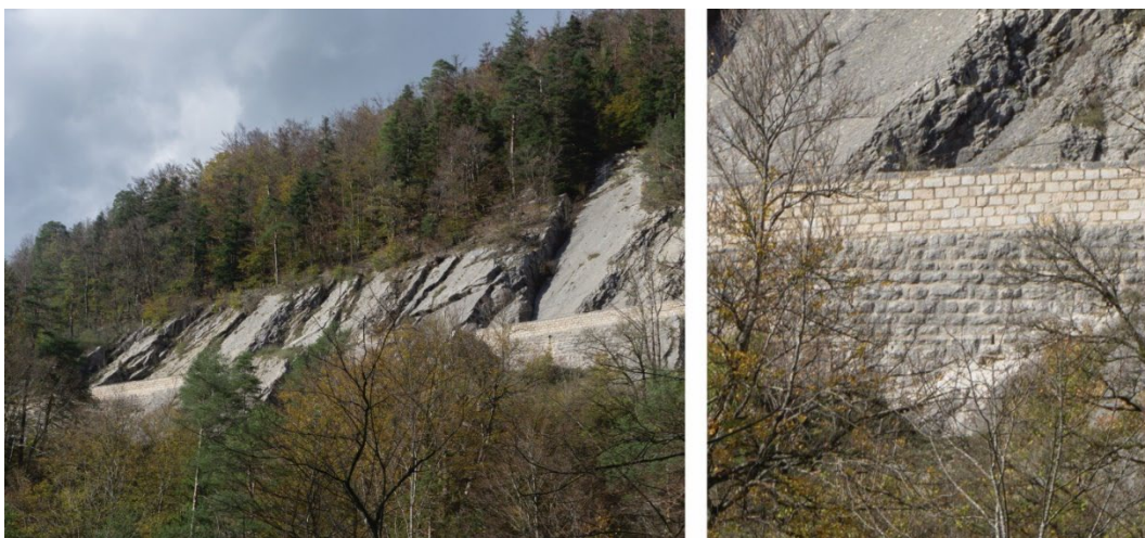
Ill. 59 Mur en pierres naturelles près de Sonceboz
