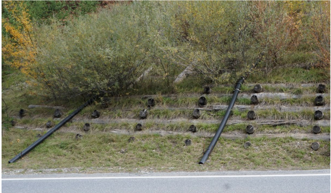
III. 20 Stabilisation de talus avec étayage en bois et plantation de saules
