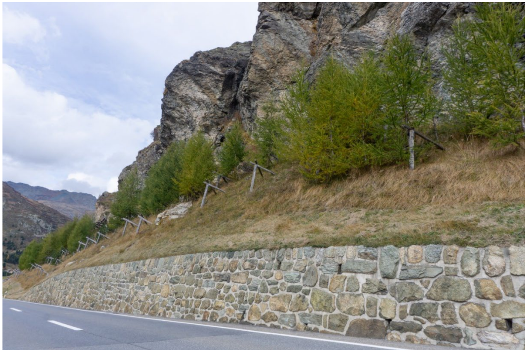
III. 9 Mur en pierres naturelles en harmonie avec les formations rocheuses avoisinantes
