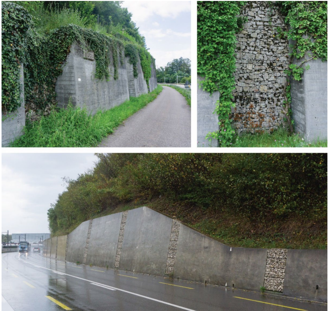
Ill. 23 Murs de soutènement en béton structurés par des gabions
