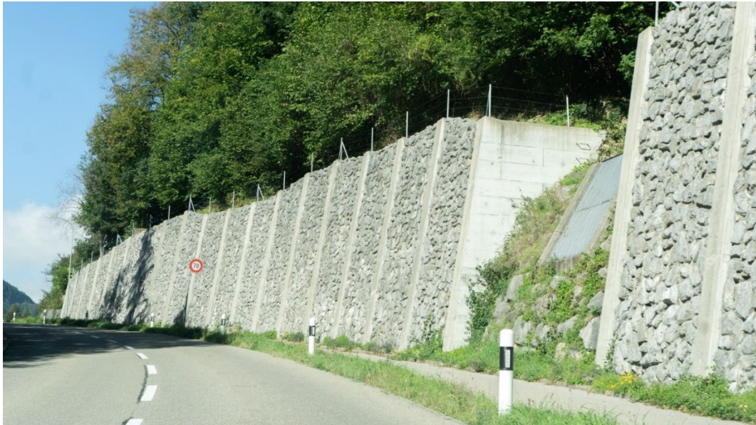
Ill. 24 Éléments en béton structurants
