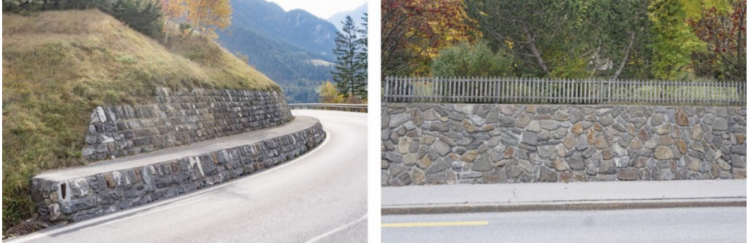
III. 58 Murs de soutènement de la route du Julier
