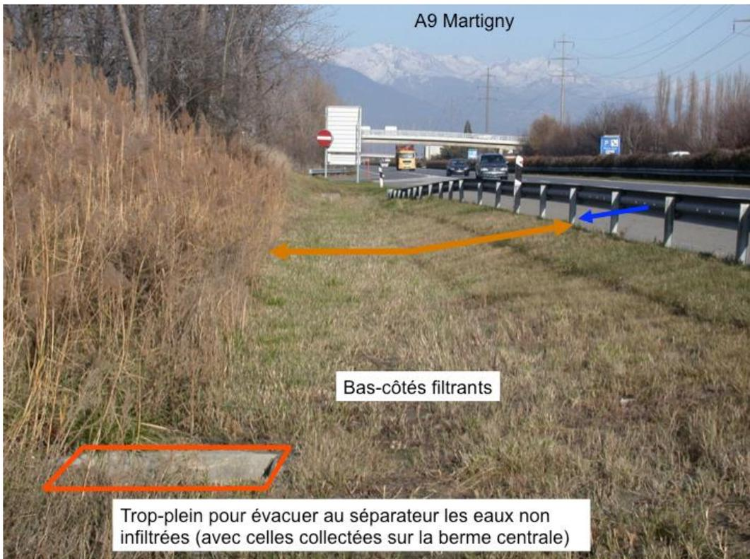
Fig. 5.9 Bas-côté et fossé infiltrant avec trop plein (A9 Martigny).
