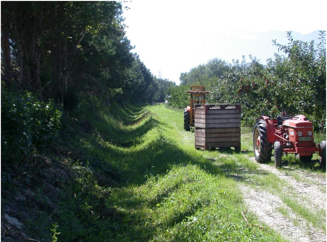
Fig. 5.7 Fossé infiltrant enherbé en contrebas du bas-côté (A9 Riddes).
