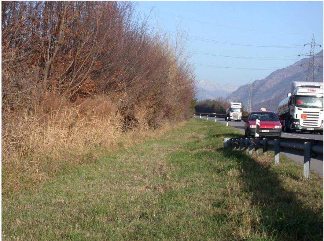
*Fig. 5.10 Bas-côté infiltrant presque plat et fossé (A9 Martigny).*
