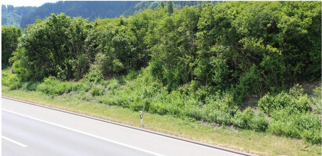
*Fig. 8 La zona a manutenzione intensiva lungo la carreggiata, con la vegetazione tenuta bassa, è facilmente riconoscibile per la frequenza degli interventi. Tutta la superficie esterna a questa striscia fa parte della zona a manutenzione estensiva.*
