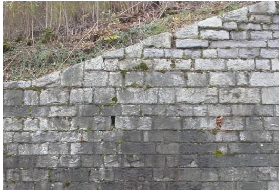
Photo 8 : Couronnement du mur légèrement décalé
