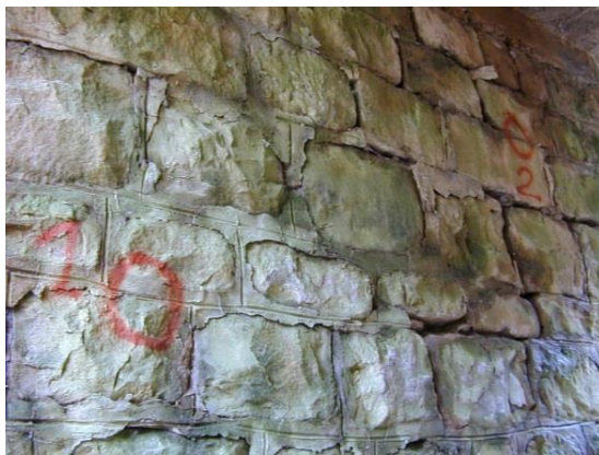
Photo 13 : Joints systématiquement arrachés
