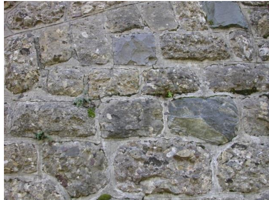
Photo 14 : Fissure de décollement du rocher (mur de parement à une couche)
