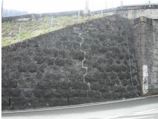
Photo 9 : Légère déformation supposée, fissure avec du mortier comme indicateur
