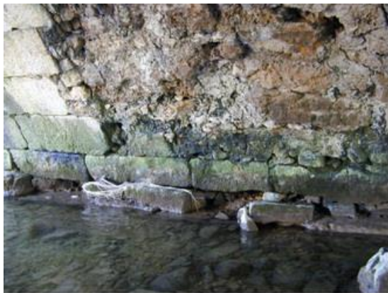
Photo 5 : Affouillement au pied du mur
