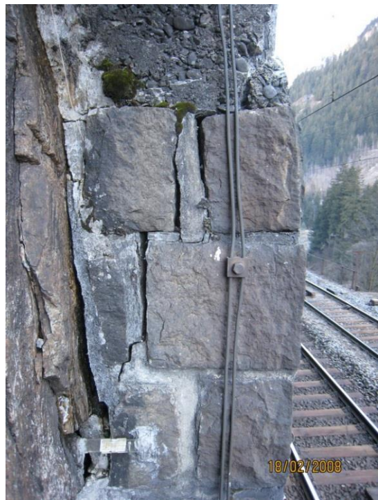
Photo 14 : Fissure de décollement du rocher (mur de parement à une couche)
