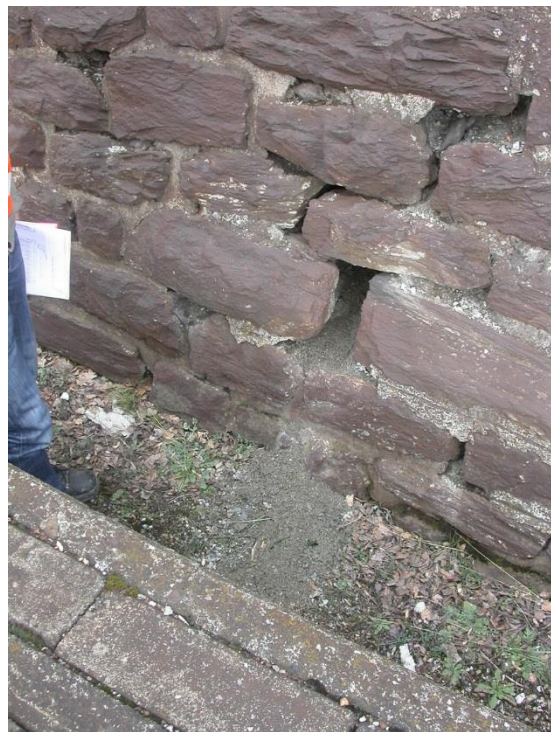
Photo 17 : Joints détériorés localement, mortier terreux-sableux
