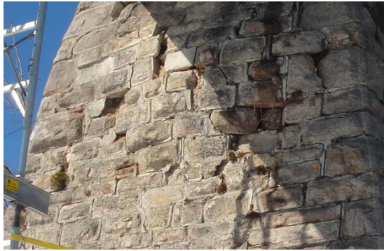
Photo 13 : Joints systématiquement arrachés
