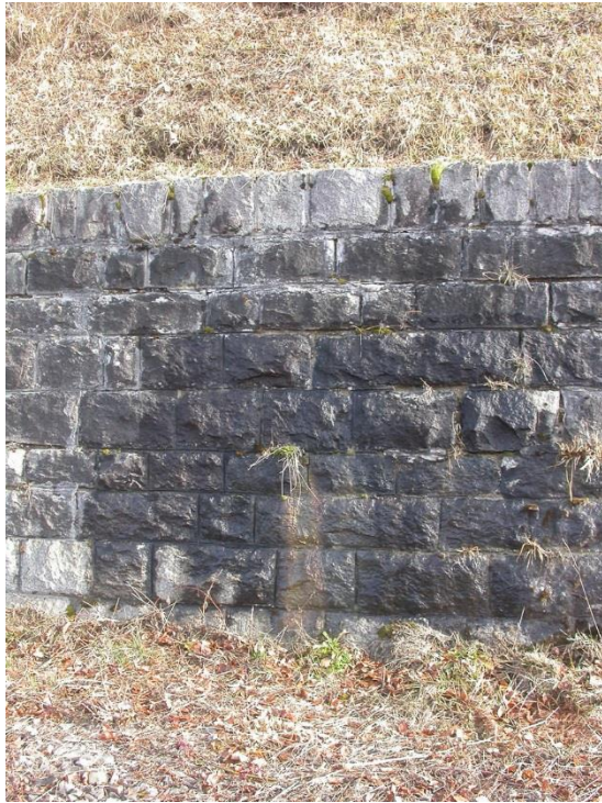
Photo 1 : Mur continuellement mouillé
