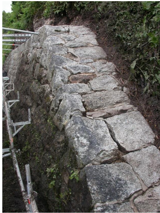
Photo 17 : Joints détériorés localement, mortier terreux-sableux
