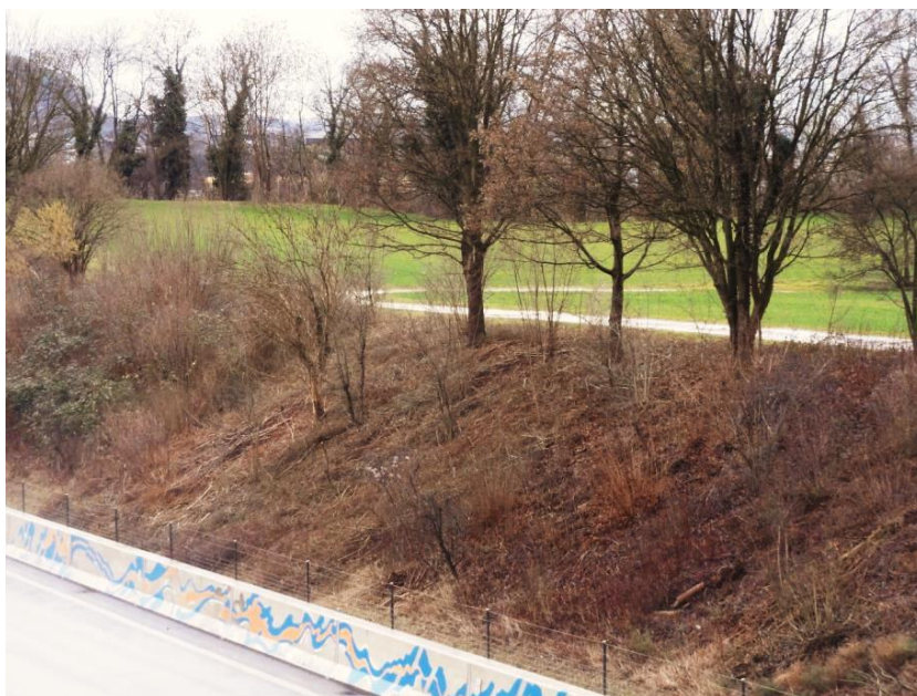
Fig. 14 Diramatura di vegetazione legnosa ridotta al 20-40% della copertura iniziale.
