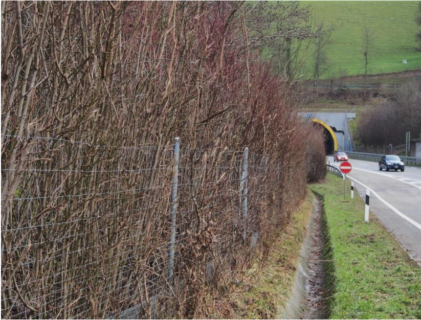
Fig. 18 Il taglio verticale consente di mantenere la funzionalità della recinzione.
