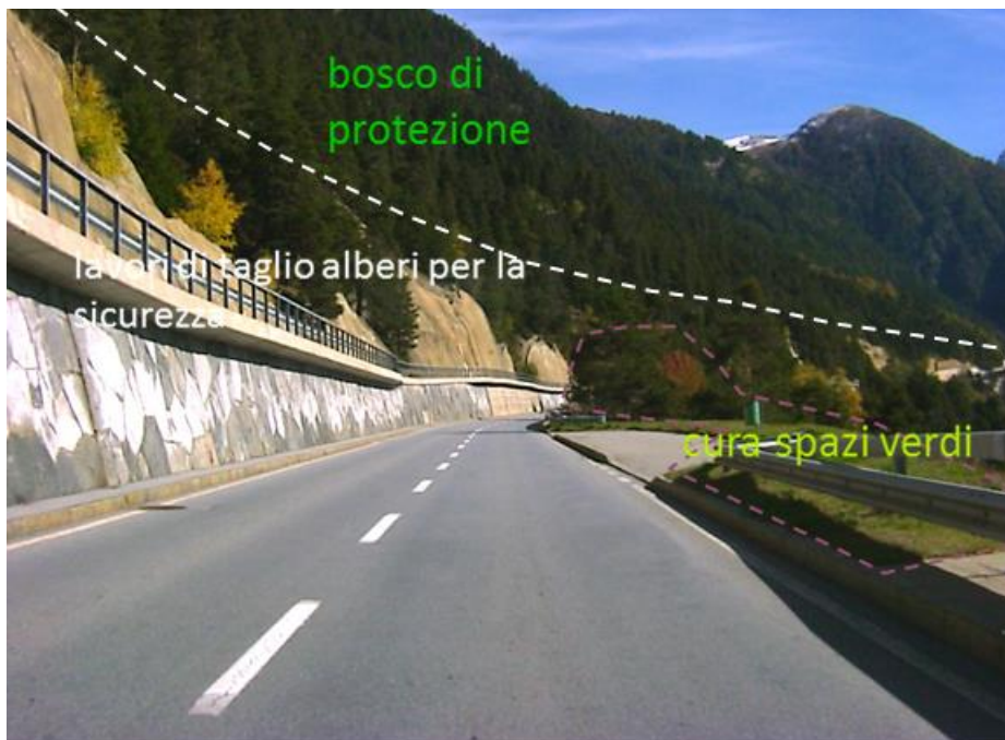
Fig. 4 Schema di delimitazione tra zona a taglio alberi, zona di manutenzione del verde e bosco di protezione.
