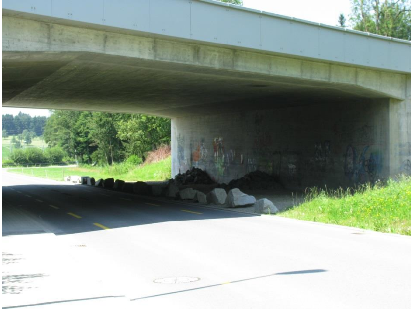
Fig. 8 Sottopasso utilizzabile anche dagli animali selvatici. Delimitando l'area con massi si crea una superficie libera non pavimentata. I cumuli di pietre rendono il luogo più invitante per la fauna.
