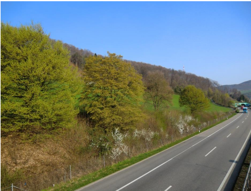
Fig. 10 La recinzione collocata nella zona a manutenzione intensiva o direttamente a ridosso della carreggiata trasforma la scarpata in uno spazio naturale e un corridoio di collegamento per la fauna.
