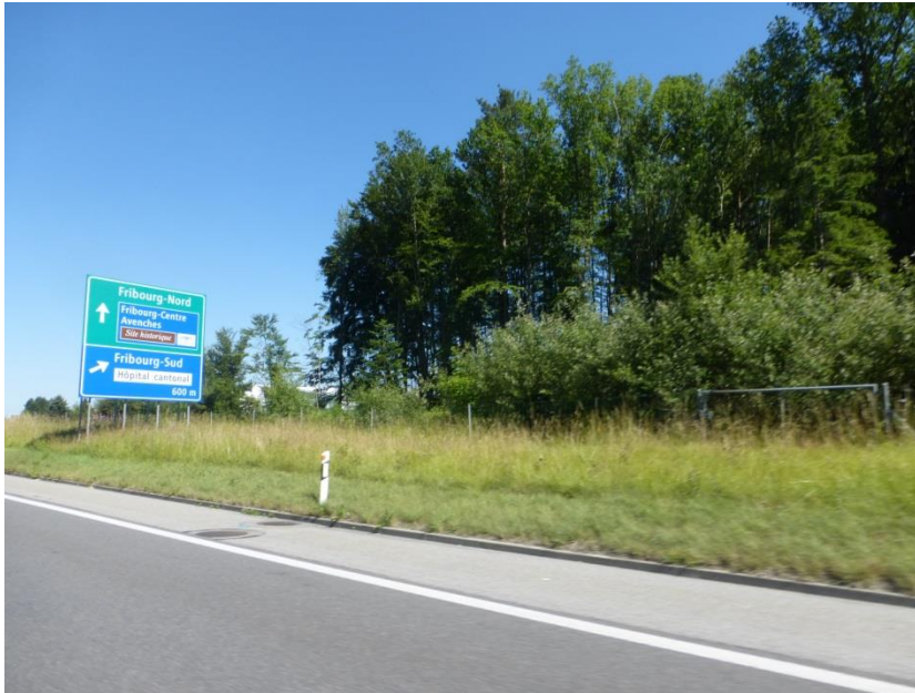
Fig. 12 La manutenzione è intensiva nei primi 2-4 m dal bordo della carreggiata.
