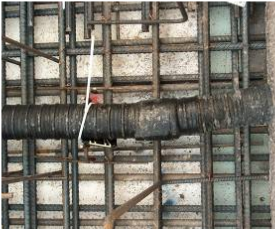
Fig. II.20 Risque de formation de plis dans la gaine en raison d'un tronçon de raccordement court.
