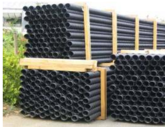
Fig. II.4 Entreposage correct des gaines.
