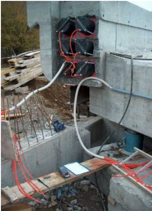
Fig. II.24 Mesures pendant la phase des travaux.
