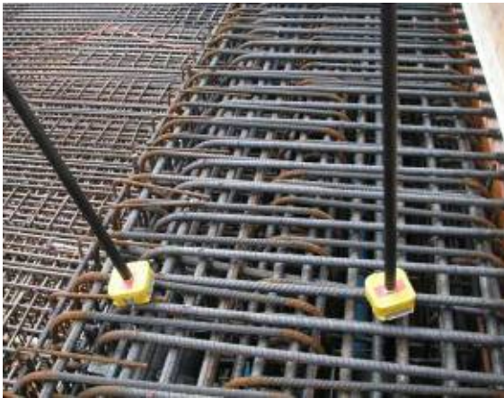
Fig. II.13 Raccords d'injection avec blocs d'évidement.
