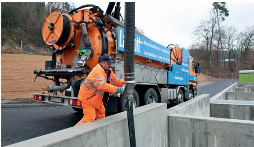
Der Bodenschlamm wird abgesogen
