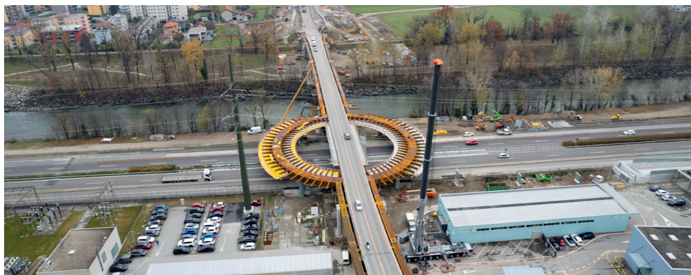
La struttura metallica della rotonda sopraelevata è stata posata lo scorso novembre
