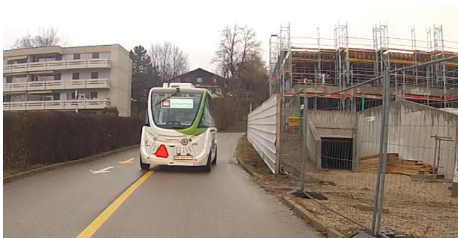
Figure 28 – Bâtiment en chantier aux Epinettes
