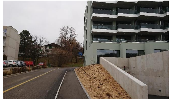
Figure 29 - Nouveau bâtiment aux Epinettes
