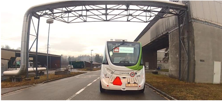
Figure 24 - Pont métallique au 1er plan et pont en béton au second plan à droite
