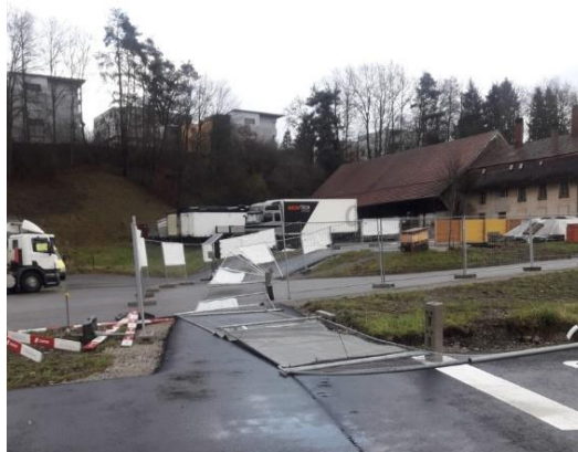
Figure 18 - Chutes des barrières suite aux vents tempétueux
