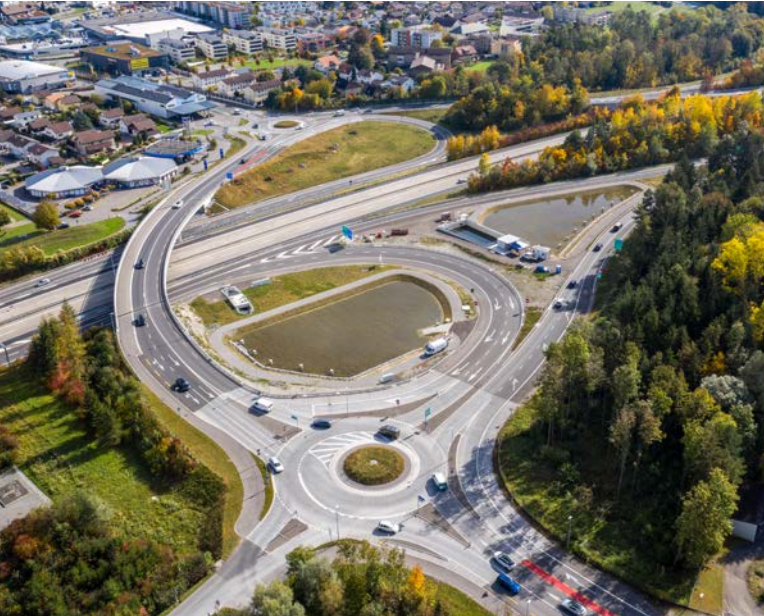
Impianto di raccolta delle acque stradali presso lo svincolo Thun Nord nel Cantone di Berna.
