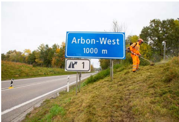
La cura del verde è parte integrante dei nostri lavori di manutenzione.
