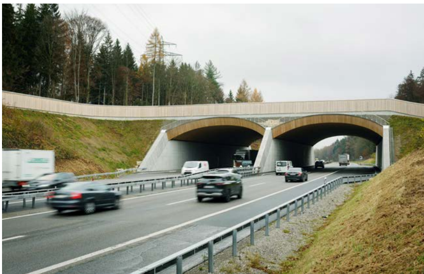
Ecodotto con elementi in legno sulla A1 in zona Rynetel tra Suhr e Gränichen nel Cantone di Argovia.
