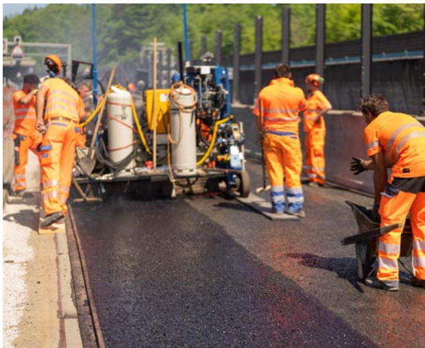
Lavori di manutenzione sull'autostrada che attraversa la città di San Gallo.
