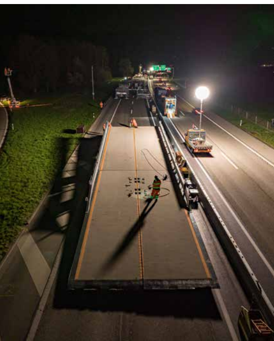
I lavori di manutenzione vengono svolti in tutta sicurezza sotto l'ASTRA Bridge. Il ponte mobile può essere trasportato da un cantiere all'altro.
