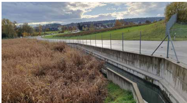
Spesso i SABA sono ricoperti dalla vegetazione, come qui presso Regensdorf.
