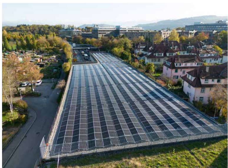
La galleria artificiale di Sonnenhof sulla strada nazionale N6 direzione Thun.
