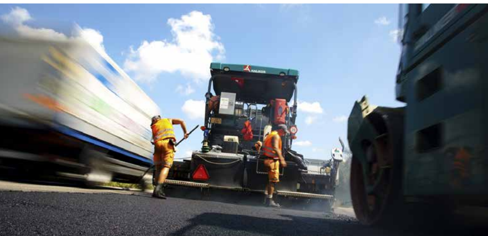
Una parte consistente delle emissioni di gas a effetto serra è legata alle attività di cantiere.
