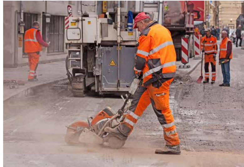
Lavori di pavimentazione presso San Gallo.
