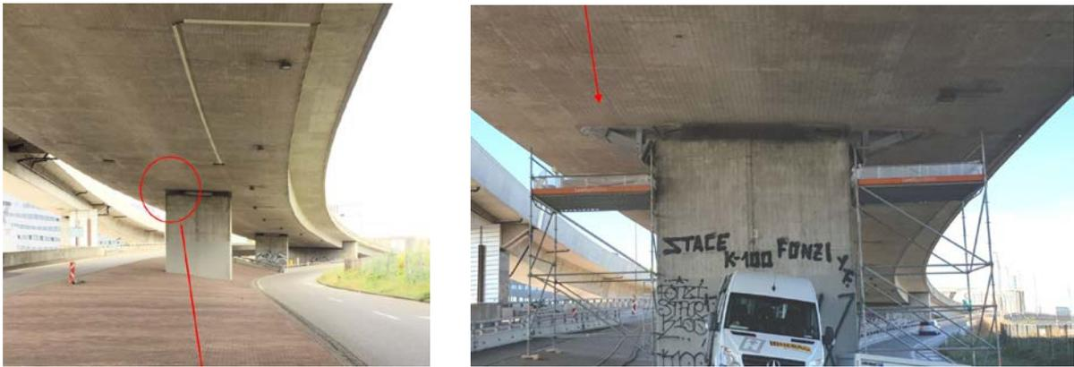
Abb. 7: Brücke Wiese: Erdbebensicherheitsmassnahmen bei den Brückenpfeilern.
