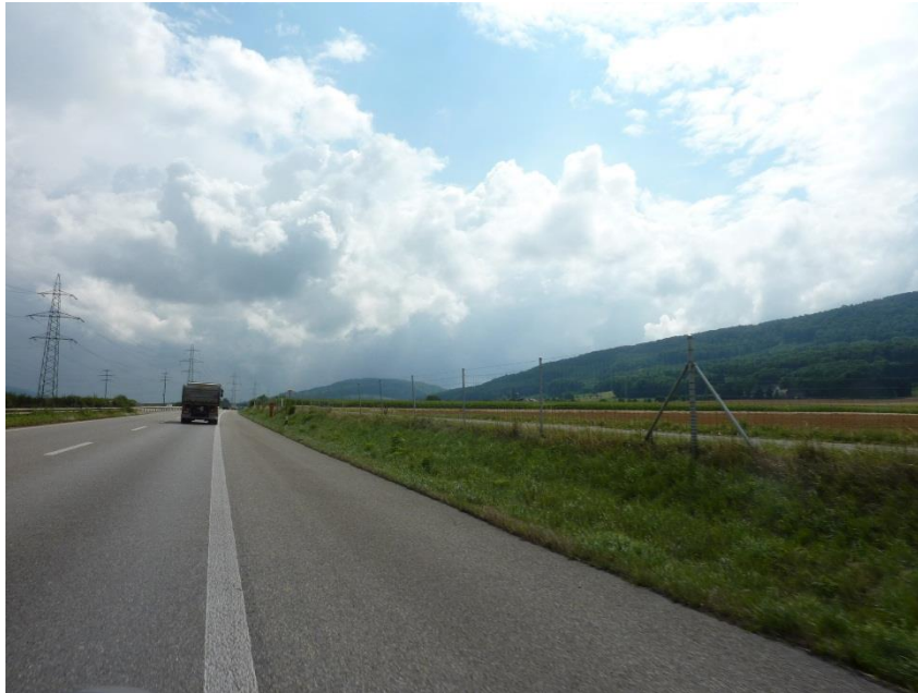
Fig. 19 Une clôture bien dégagée avec un espace disponible limité.
