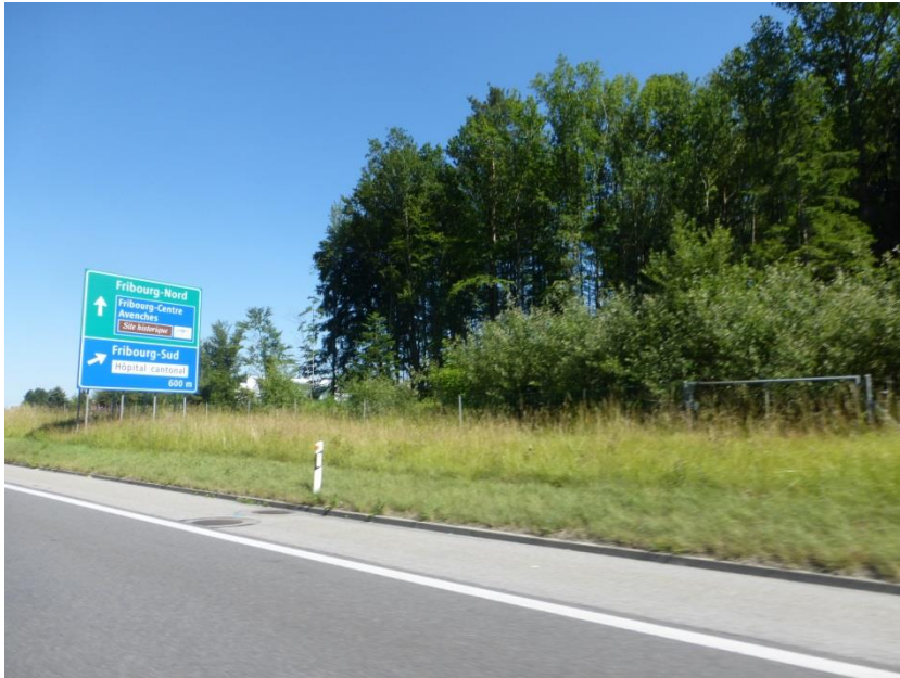
Fig. 12 Sur les 2 à 4 m à partir du bord de la chaussée, l'entretien est intensif.
