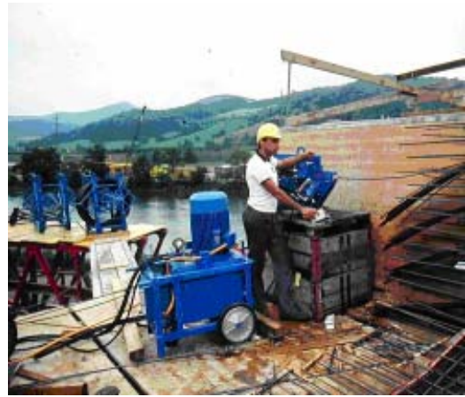
Fig. II.2 Gaines et torons préalablement posés avant le bétonnage.
