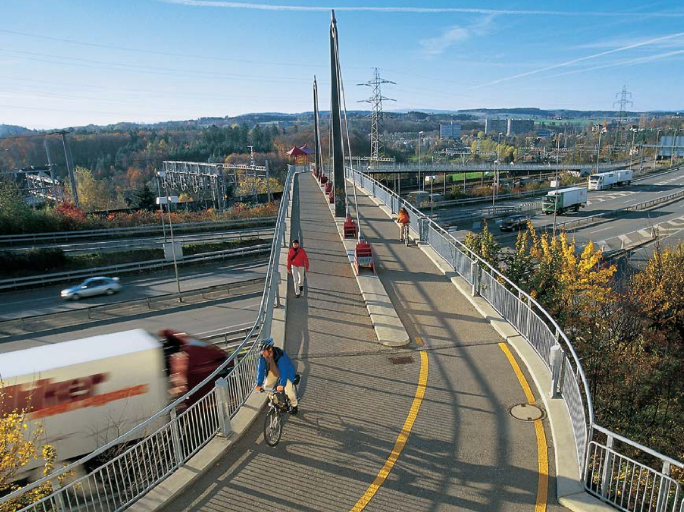
Huit voies de circulation pour le trafic motorisé et deux pour la mobilité douce (échangeur N1/N6 à Berne – Wankdorf)
