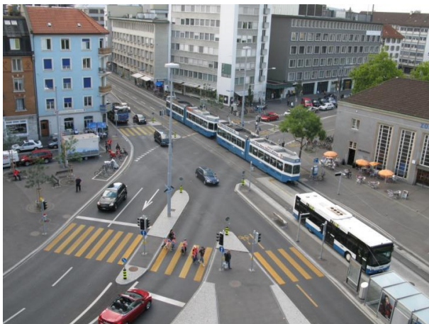
L'intersection Schimmel-/Birmensdorferstrasse avant la transformation (2008)
