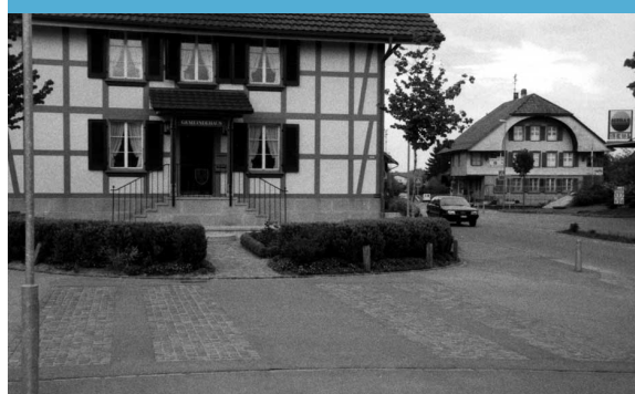
Des pavages permettent une liaison continue sans marches et seuils. Ce n'est que sous cette forme-là que les chemins pédestres sont accessibles à tous.
