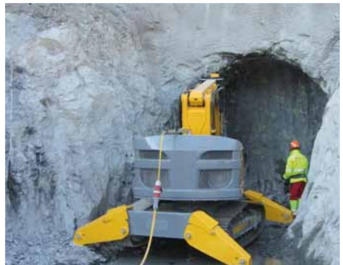
Bau Startröhre für Tunnelbohrmaschine
