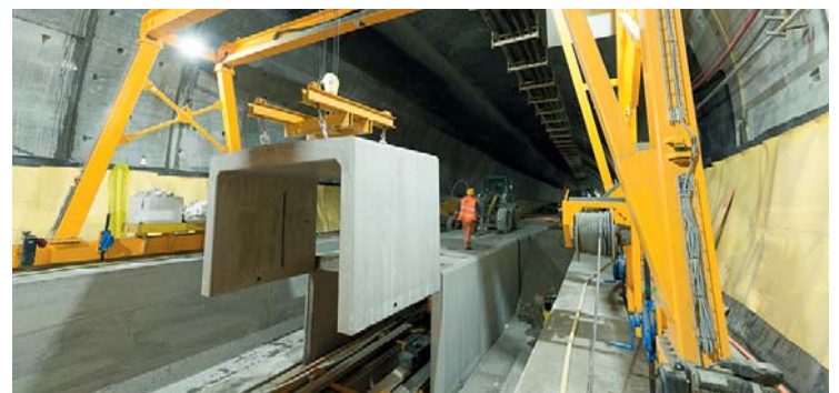
Sektor C: Der Werkleitungskanal wird später von der Fahrbahn überdeckt.
