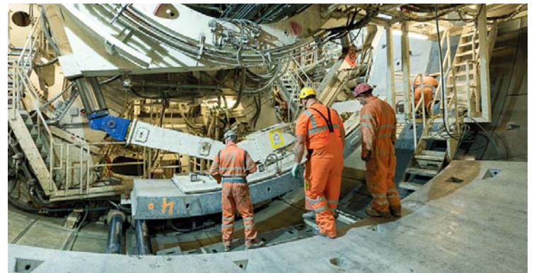
Sektor B: Per Vakuum hält und bringt der Greifarm die Tübbinge in Montageposition.
