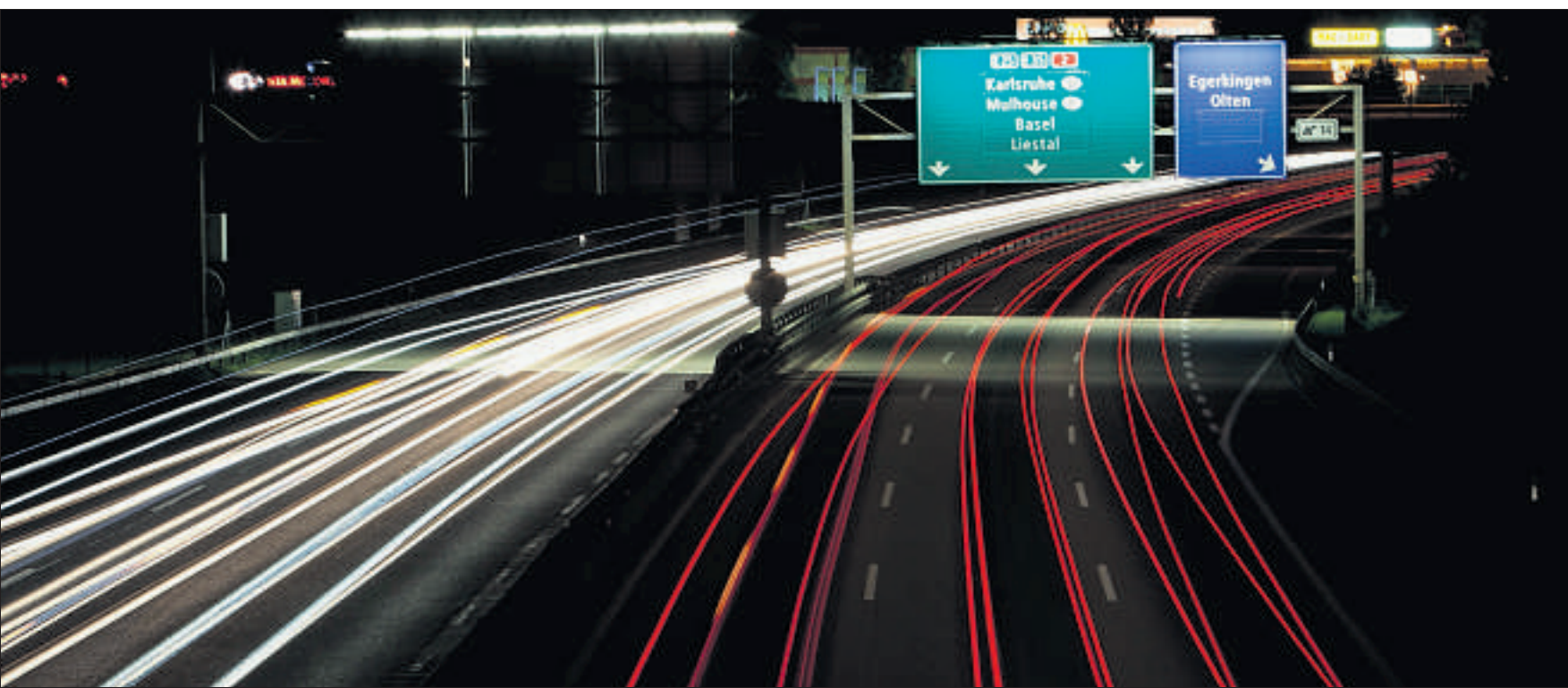
Unbeleuchtete Ausfahrt Egerkingen auf der A 2: So dunkel soll es nach dem Willen des Astra auf fast dem gesamten Nationalstrassennetz werden. (10. 7. 2011)
