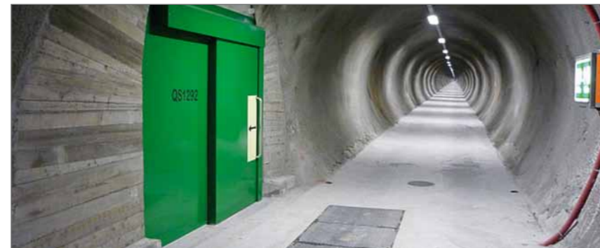
Zugang zu Sicherheitsstollen
