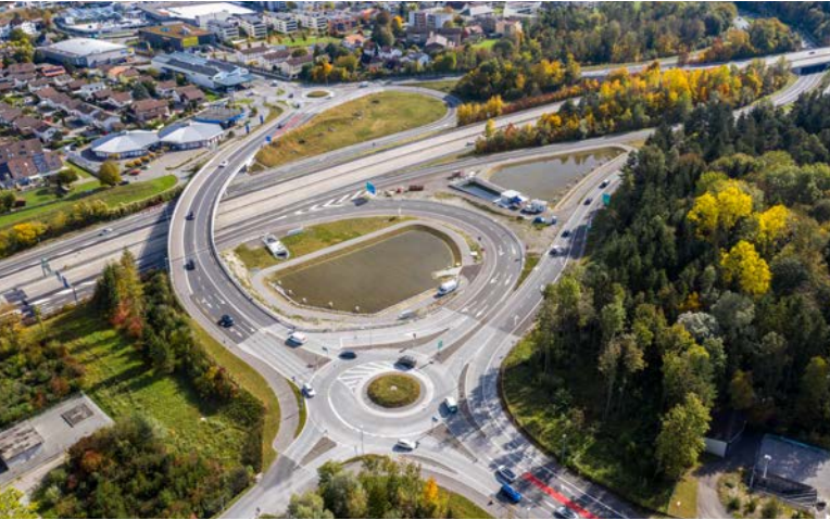
Installation de traitement des eaux de chaussée au niveau de la jonction d'autoroute de Thoune Nord, dans le canton de Berne
