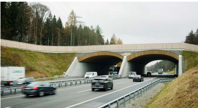
Passage à faune avec des éléments en bois surplombant l'autoroute A1 aux environs de Rynetel entre Suhr et Gränichen, dans le canton d'Argovie.
