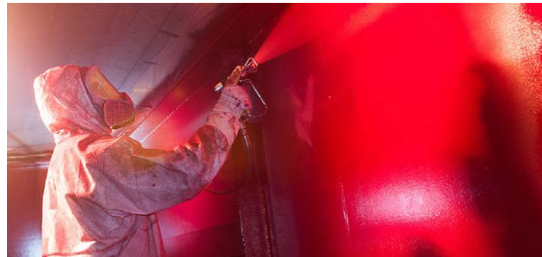
Une peinture anti-corrosion est appliquée sous la couche de protection.
