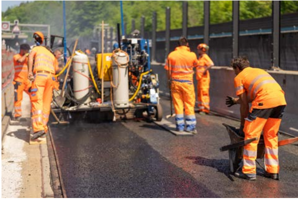
Travaux de remise en état sur l'autoroute urbaine de Saint-Gall
