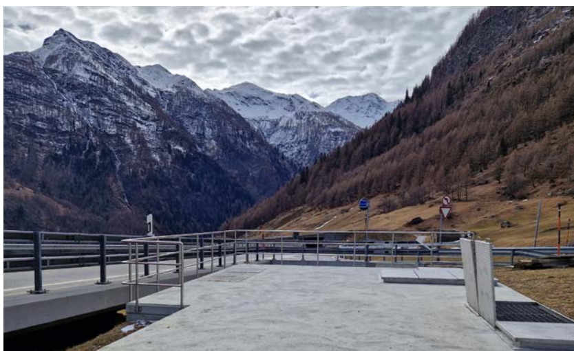
Bassin de rétention de Krummenbach sur l'A9 au col du Simplon
