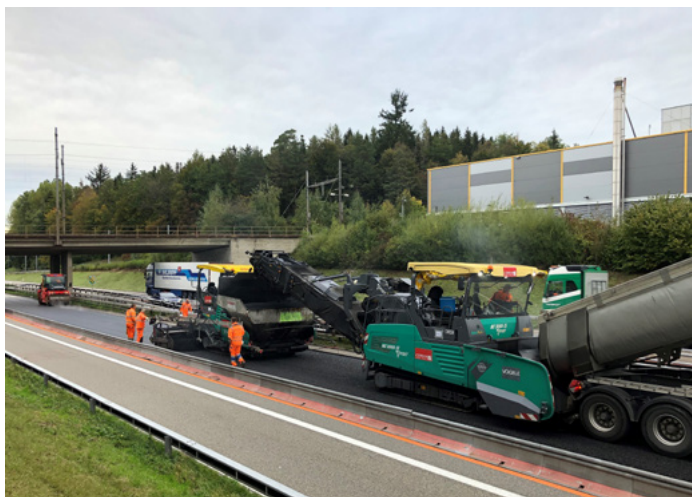
À gauche: recyclage du béton entre Airolo et Quinto (TI). À droite: remplacement du revêtement près de Wil (SG).
