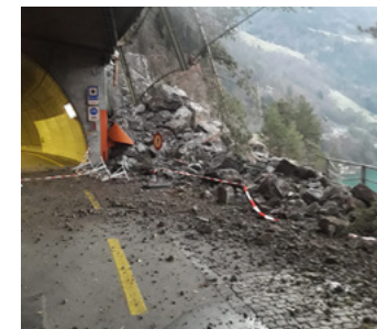
Ci-dessus: un éboulement sur l'Axenstrasse.
