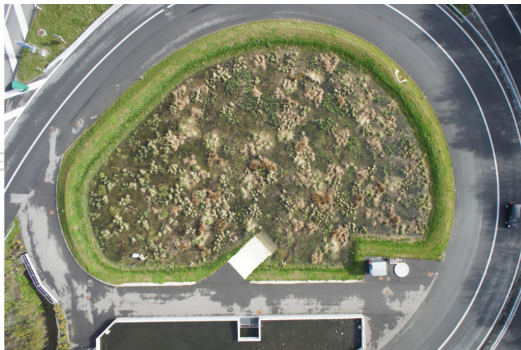
Ci-dessus: système d'évacuation et de traitement des eaux de chaussée de Hallmatt sur l'A12.
