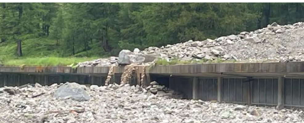
Fin juin 2024, une lave torrentielle a enseveli la route nationale au col du Simplon et s'est engouffrée dans la galerie Engi.
