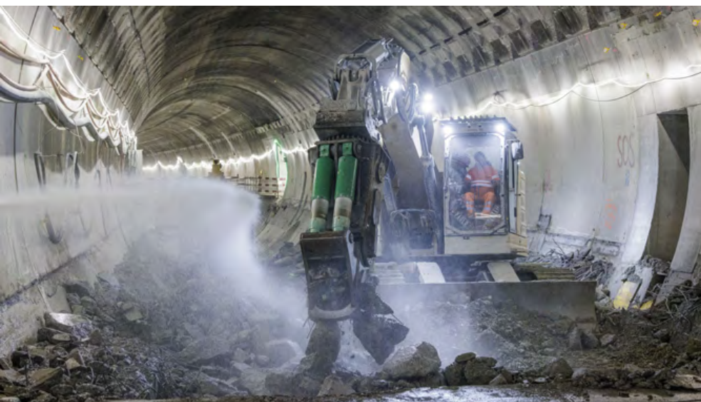
Les anciens ouvrages des routes nationales peuvent contenir des substances problématiques.
