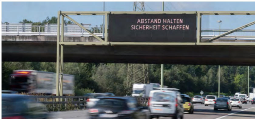
Les panneaux à messages variables peuvent contribuer à prévenir les accidents.
