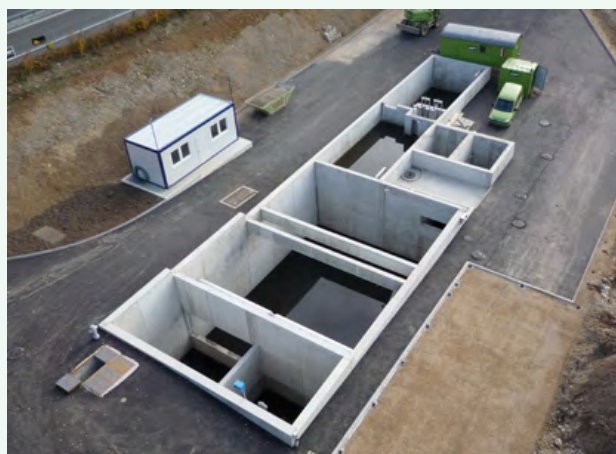
La SETEC Pfaffensteig à Bümpliz (Berne), construit il y a 15 ans, est le plus ancien SETEC technique de Suisse.
