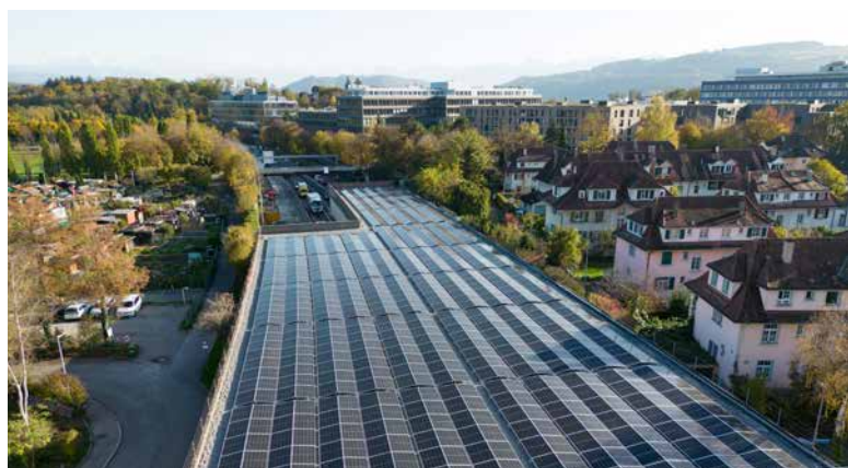
Tranchée couverte du Sonnenhof de la route nationale N6 vers Thoune.
