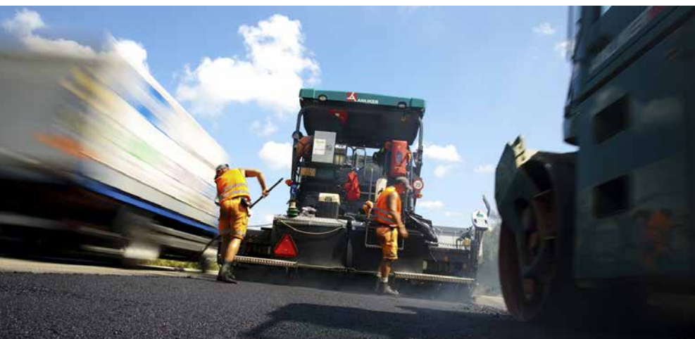
Une grande partie des émissions de gaz à effet de serre provient des chantiers.
