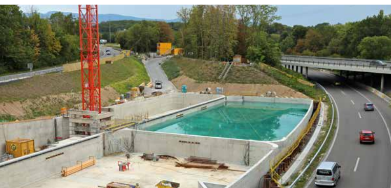
Un nouveau système d'évacuation et de traitement des eaux de chaussée (SETEC) est en construction sur l'A9, entre Lausanne-Vennes et Chexbres (canton de Vaud).
