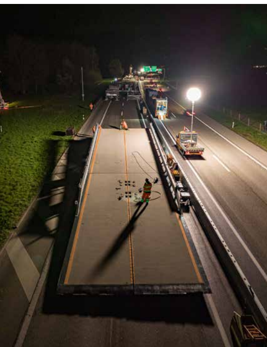
Sous l'ASTRA Bridge, les travaux d'entretien peuvent être réalisés en toute sécurité. Ce pont mobile peut être transporté d'un chantier à un autre.
