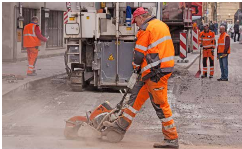
Travaux de revêtement à Saint-Gall.
