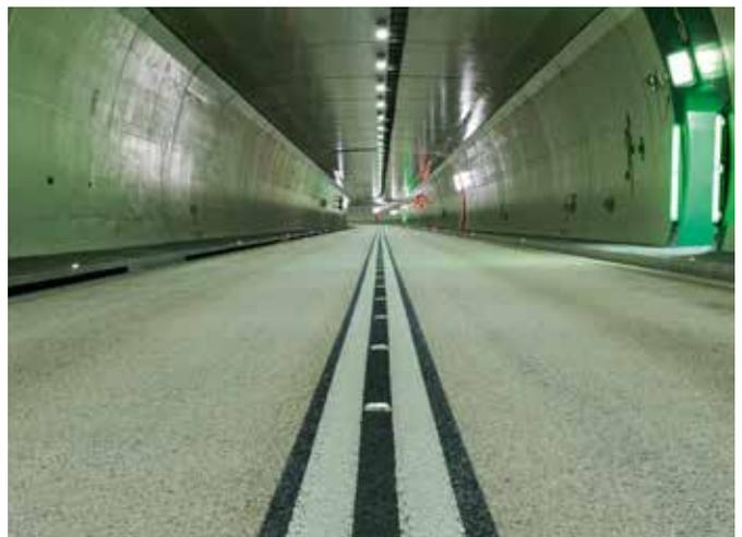
*Dans le tunnel de Lungern, quatre tronçons ont été aménagés de manière différente pour ce qui est de la couleur des parois et de l'asphalte. L'étude visait à observer les conséquences de la clarté sur la consommation d'électricité dans le tunnel.*
