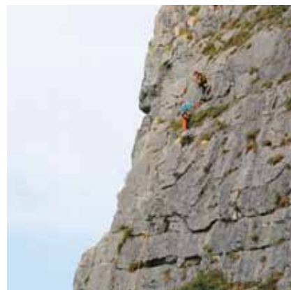
La purge des parois rocheuses est l'affaire des alpinistes.
