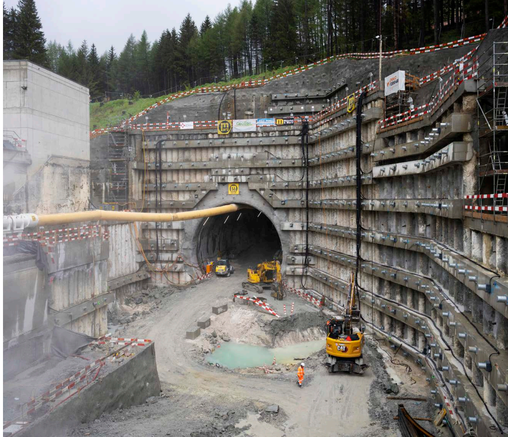
Sécurisation du terrain et début du percement au portail sud du deuxième tube du tunnel routier du Gotthard à Airolo/TI.
