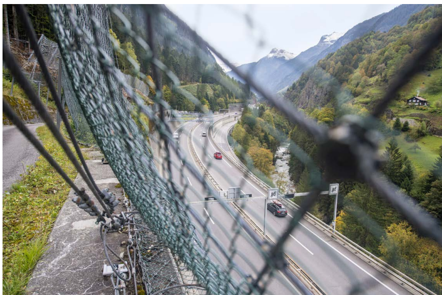
Filet de sécurité et de protection contre les dangers naturels le long de l'A2, entre Amsteg et Göschenen/UR.
