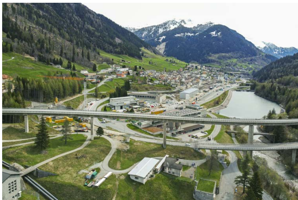
Chantier du deuxième tube du tunnel routier du Gotthard, à Airolo.
