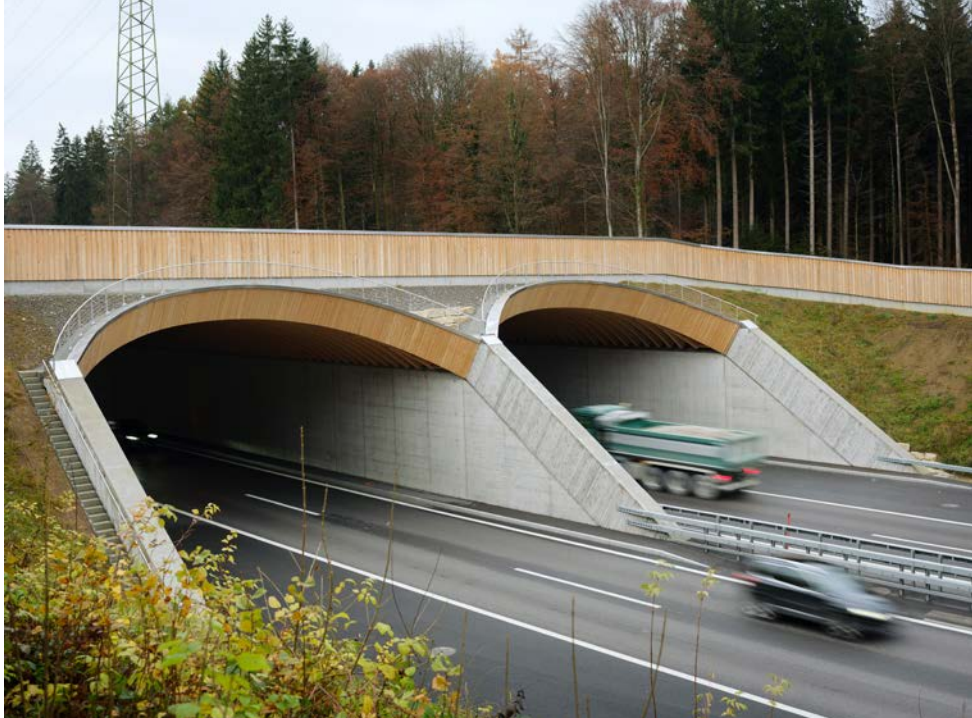
Passage à faune végétalisé au-dessus l'A1, près de Suhr.
