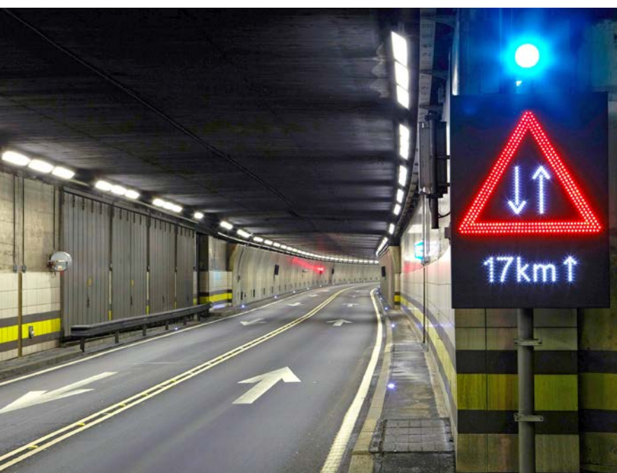
A2, tunnel routier bidirectionnel du Gotthard.
