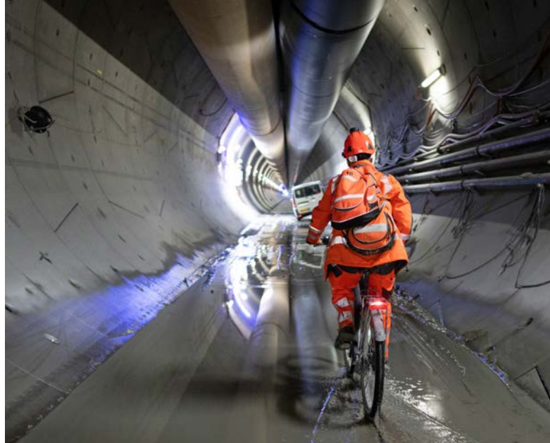
Un ingénieur en route vers le chantier de la caverne de montage pour la construction du deuxième tube du tunnel routier du Gotthard.
