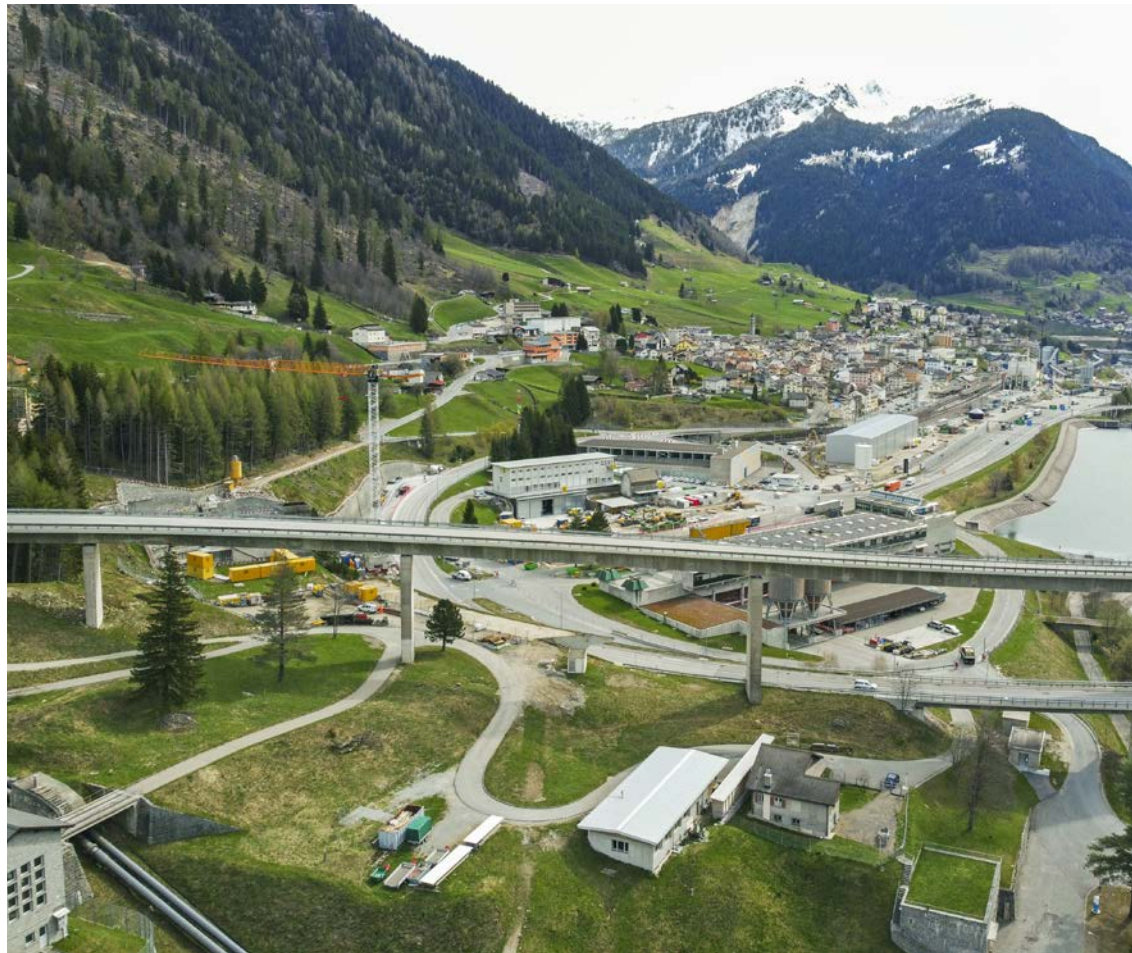
Chantier du portail sud du deuxième tube du tunnel routier du Gotthard.
