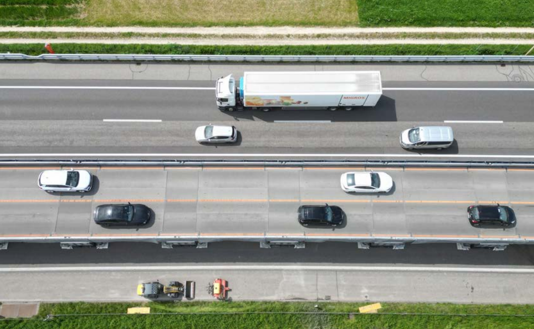
L'ASTRA Bridge mobile sur l'A1, entre Kriegstetten et Rechterswil.
