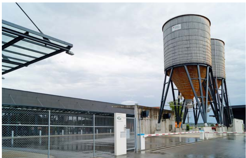
Installation de chargement de sel moderne à commande numérique au centre d'intervention de Müllheim.
