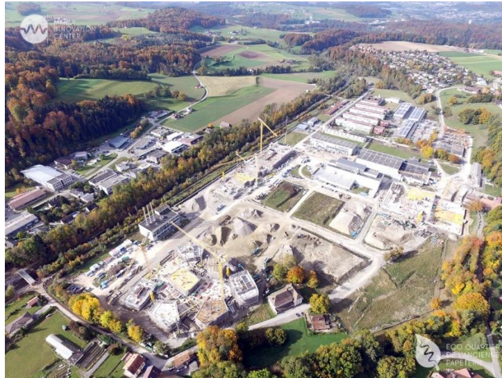
Figure 14 - Travaux du nouvel écoquartier (Source : MIC)
