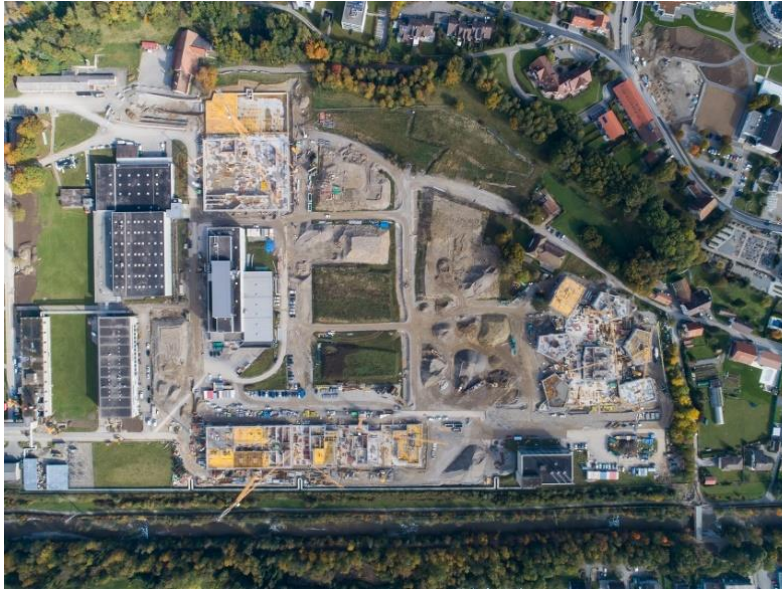
Figure 4 - Travaux sur le MIC (Source : Groupe E)
