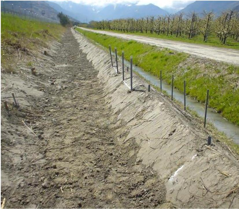
Abb. 5.6 Bau eines Infiltrationsgrabens (A9 Riddes).
