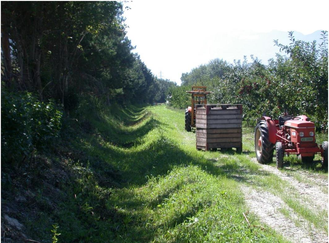
Abb. 5.7 Begrünter Infiltrationsgraben unterhalb der Böschung (A9 Riddes).
