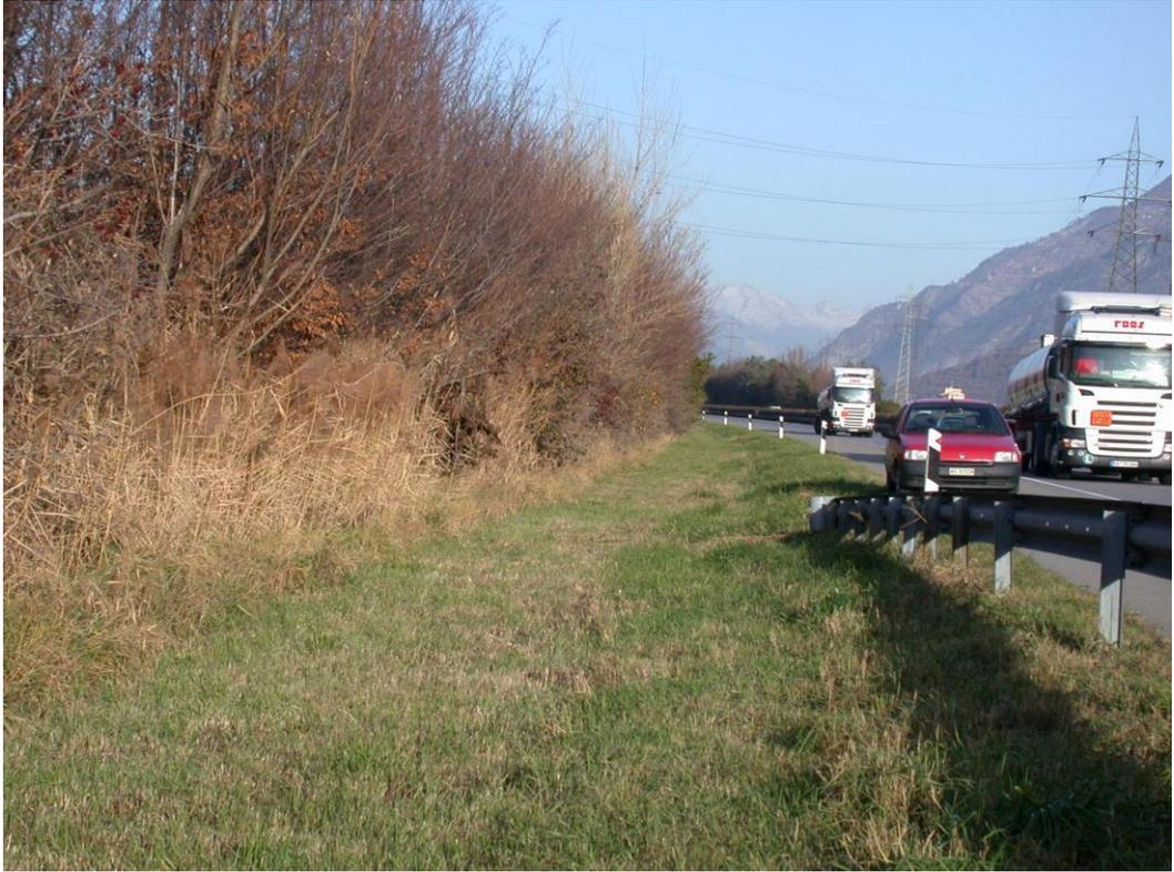
Abb. 5.10 Beinahe flache infiltrierende Böschung und Graben (A9 Martigny).
