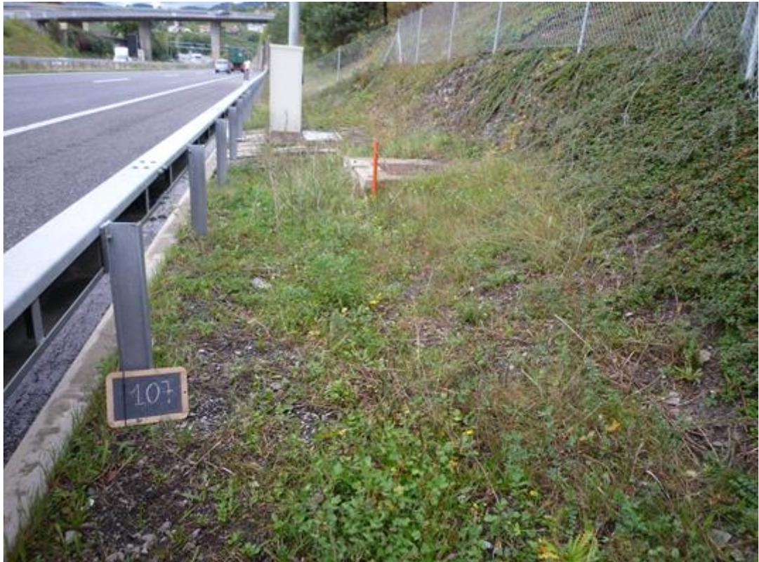
Abb. 4.4 „Schulter mit unbestimmter Versickerung“ am Standort „ZHAW-107“ (Bild: Simon Amrein, ZHAW).
