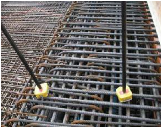
Abb. II.13: Injektionsanschlüsse mit Aussparungskörpern.
