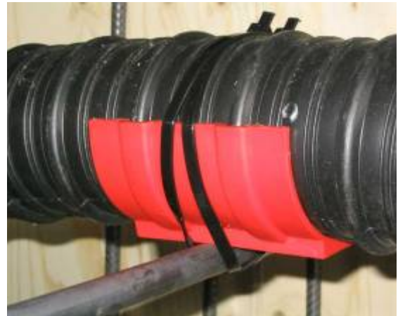
Abb. II.12: Schutzschalen und Binder aus Kunststoff.
