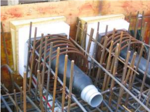
Abb. II.5: An Schalung befestigte Verankerungen.
