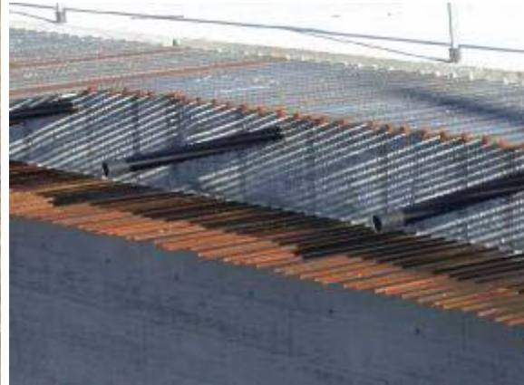
Abb. II.21: Ausreichende Überlänge zur Erreichung gleichmässiger Spanngliedkrümmung.
