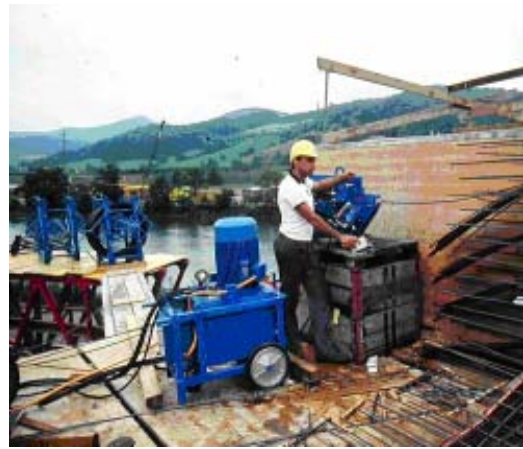
Abb. II.2: Vorverlegte Hüllrohre und Litzeneinstossen vor dem Betonieren.
