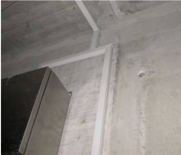
Abb. II.15: Nachträgliche Aufputzinstallation z.B. in geschützter, abgeschlossener Widerlagerkammer.
