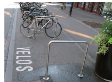
Pfosten und Bügel ermöglichen das Anlehnen des Velos und die Sicherung des Rahmens.
