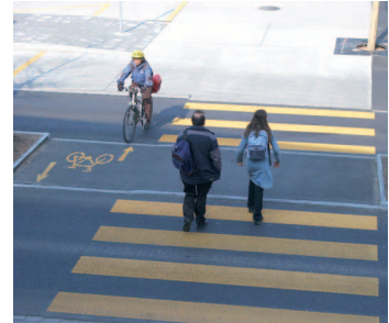
Die Zufahrt führt neben dem Fussgängerstreifen auf einer Velofurt über die Strasse. Damit können Konflikte mit Zufussgehenden minimiert werden (Affoltern a.A. ZH).
