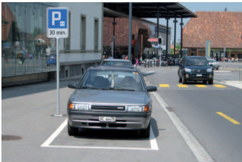
Die Parkierung am Fahrbahnrand verhindert gefährliche Parkiermanöver. Der Abstand von 50 cm zum Fahrbahnrand entschärft Konflikte mit dem Veloverkehr beim Öffnen der Türen (Köniz BE).
