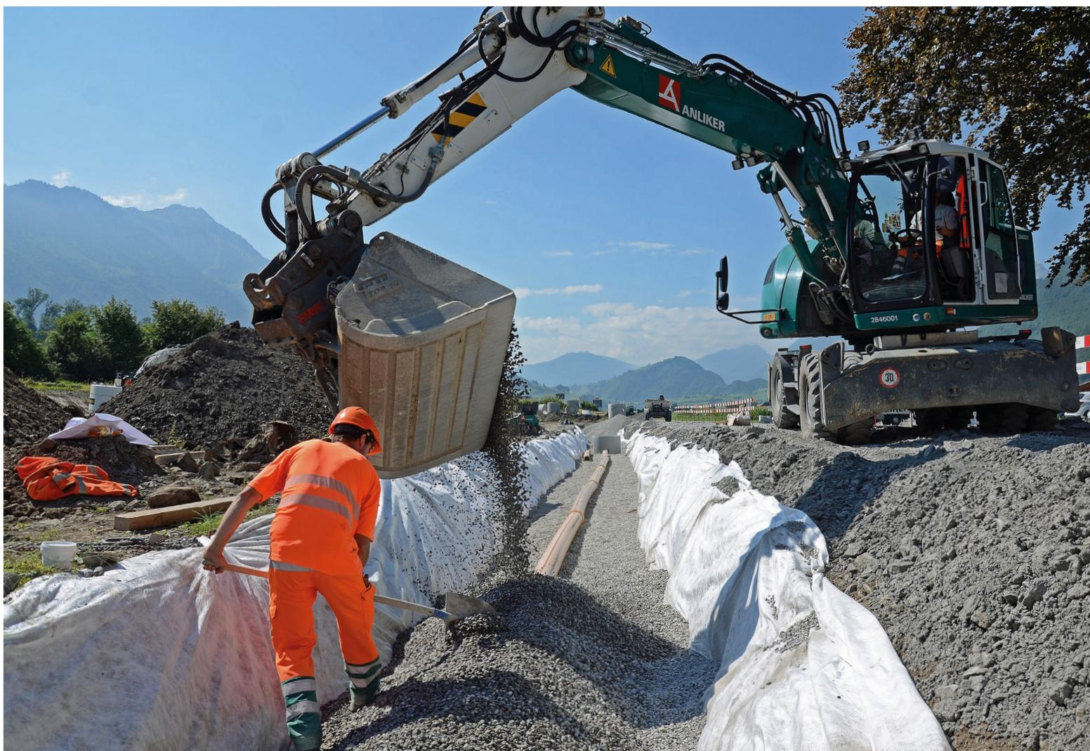
Auf dem Grundstück Faden in Buochs entsteht eine der insgesamt vier Strassenabwasser-Behandlungsanlagen (SABA), in denen das auf dem Streckenabschnitt Stansstad bis Beckenried anfallende Abwasser in einem mehrstufigen Verfahren gereinigt wird.
