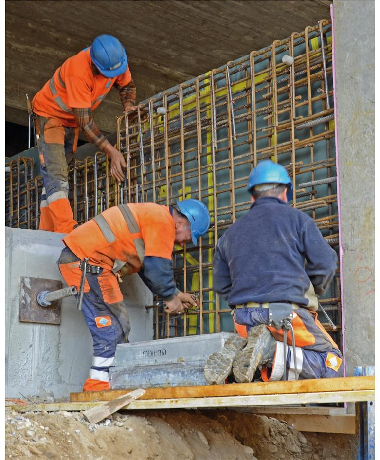
Für die Benutzer der Autobahn nicht einsehbar ist die Verstärkung der talseitigen Fundamente beim Viadukt Blauhaus.
