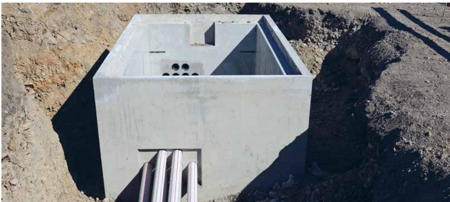
In den Schalträumen erfolgt Feinverteilung der in den Kabelrohrblöcken zugeführten Leitungen.
