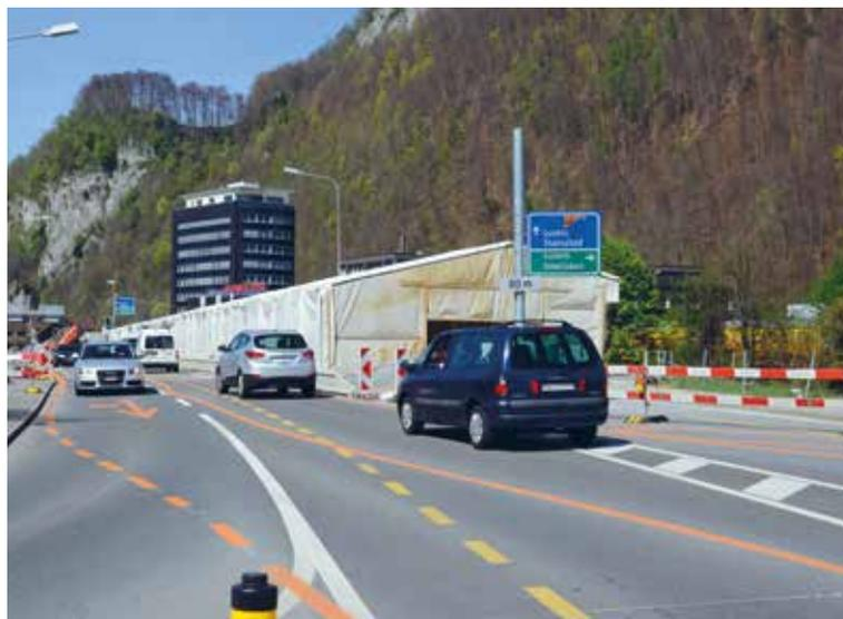
Das Schutzzelt für wetterunabhängiges Bauen steht nun über der auf dem Bild links verlaufenden Fahrspur.
