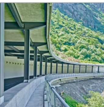
Tristelboden: Erneuerung des Korrosionsschutzes einer talseitigen Leitmauer; Abschlussmauer; Sicherung des als abgegrabenem Galeriegedächts; Sanierung; Neuerstellung Trassee.
