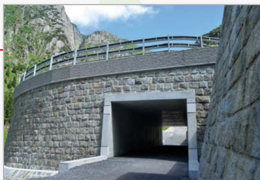
Bäckkehr: Bau des Trassees für den Langsamverkehr ab Dach Galerie Tanzenbein bis zur alten Gotthardstrasse; Bau einer Unterführung für den Langsamverkehr in der unteren Wendeplatte zur Sicherstellung der Kreuzungsfreiheit mit dem Strassenverkehr.
