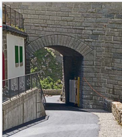
Teufelsbrücke (Gebiet Restaurant Teufelsbrücke): Neubau des Trassees für den Langsamverkehr entlang der reussseitigen Felsböschung beim Parkplatz; Bau einer Unterführung durch das südliche Widerlager der Teufelsbrücke.
