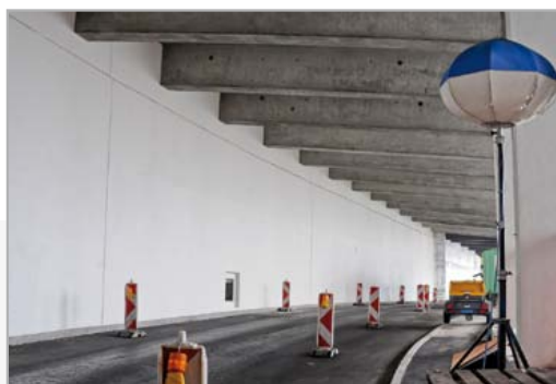
Tunnel Urnerloch: Neubau des Tunnels; Umleitung des Verkehrs (einspurig mit Ampelsteuerung auf Bahntrasse); während zweimal vier Wochen komplette Tunnel-sperrung.
