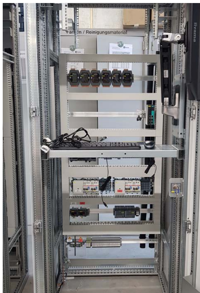
Für die Werksprüfung werden die Schaltschrankaufbauten für die Lüftungssteuerung aufgebaut und miteinander verkabelt.
