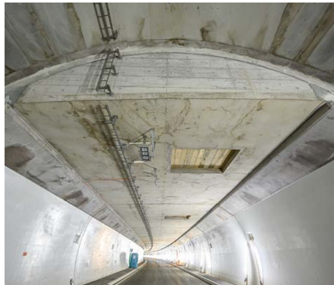
Entlang des Trassees für die Kabelverlegung der Tunnelbeleuchtung sorgen künftig 750 LED-Leuchten für eine perfekte Ausleuchtung des Tunnelinnern.
