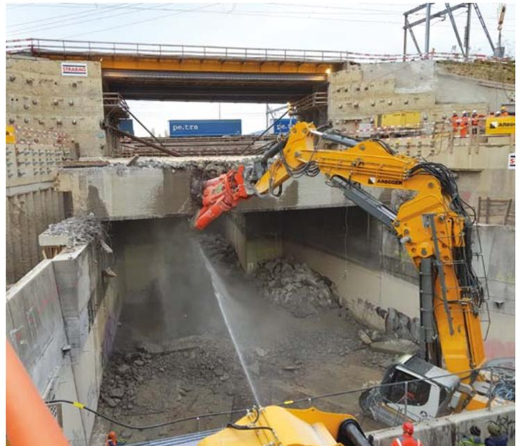
Der Rückbau des Tunnels Hagnau wurde unter anderem mit dem A-Rex M9300, dem grössten Rückbaubagger Europas, bewerkstelligt.
