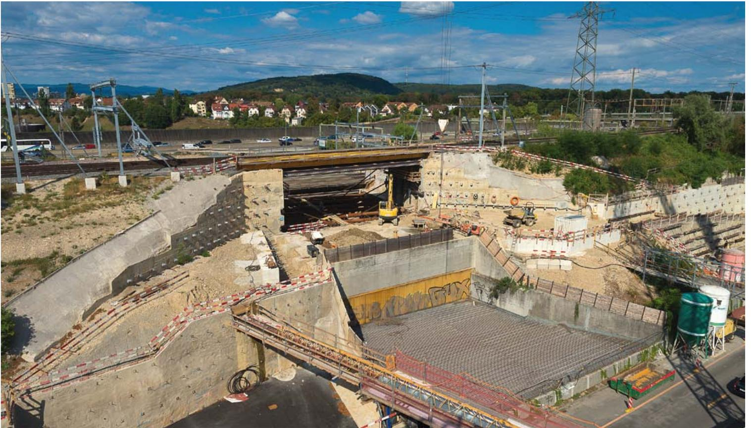
Blick auf das über dem Tunnel Hagnau liegende Gelände. Ende November wurde der Tunnel Hagnau abgebrochen. Dies unter anderem mit dem grössten Rückbaubagger Europas.
