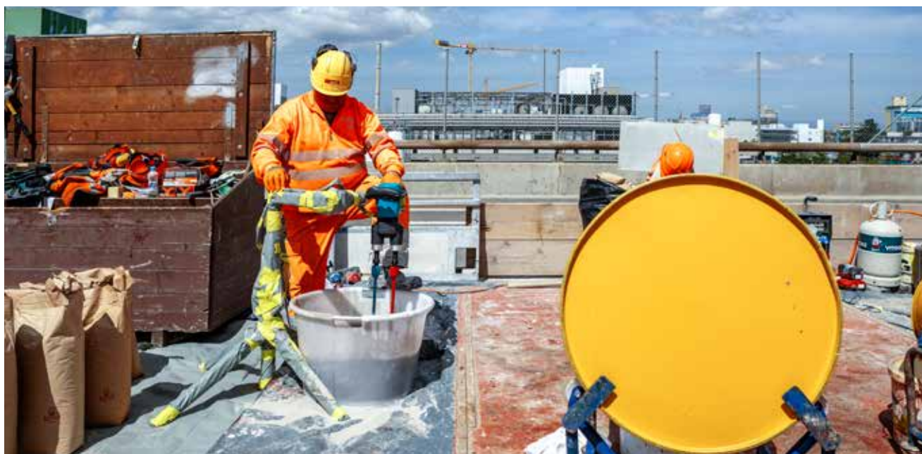
Feinarbeiten werden sorgfältig von Hand erledigt.
