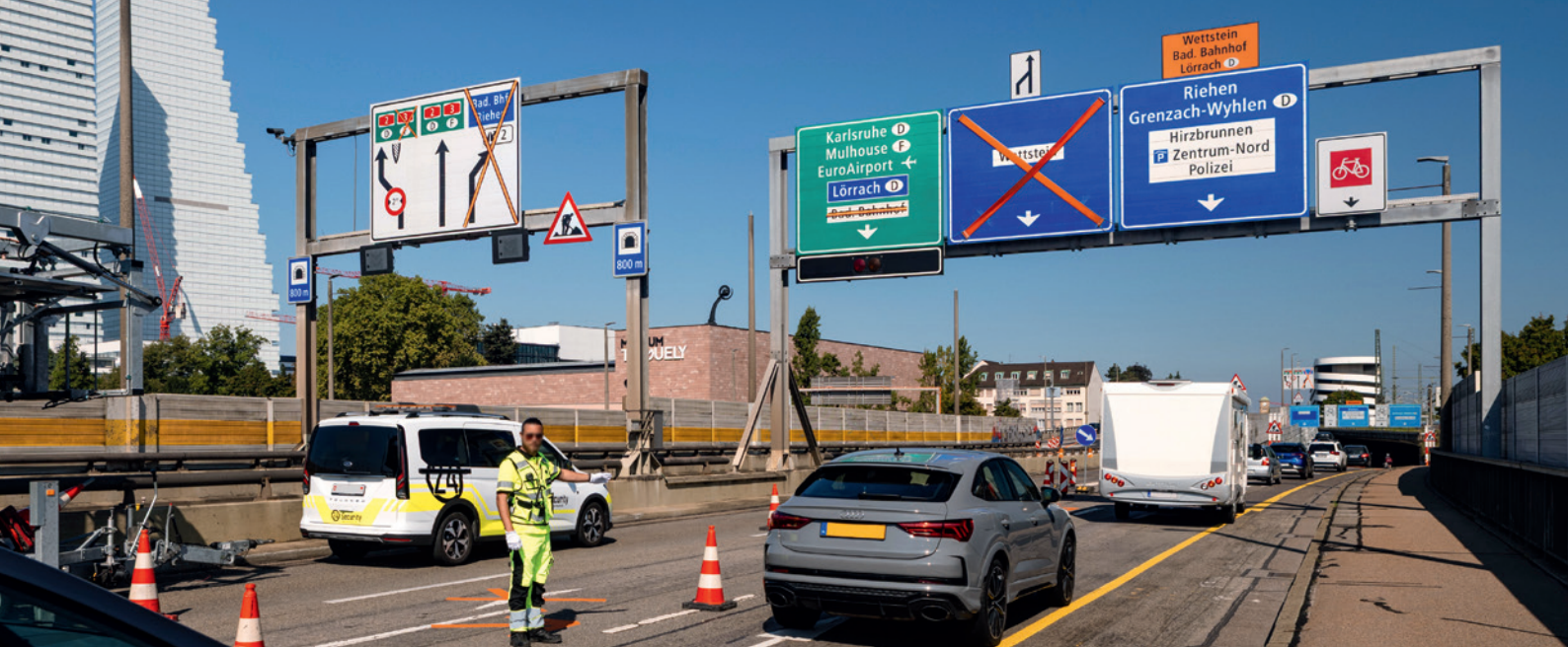
Während der Vollspernung wurde der Verkehr auf das nachgelagerte Strassennetz abgelenkt.
