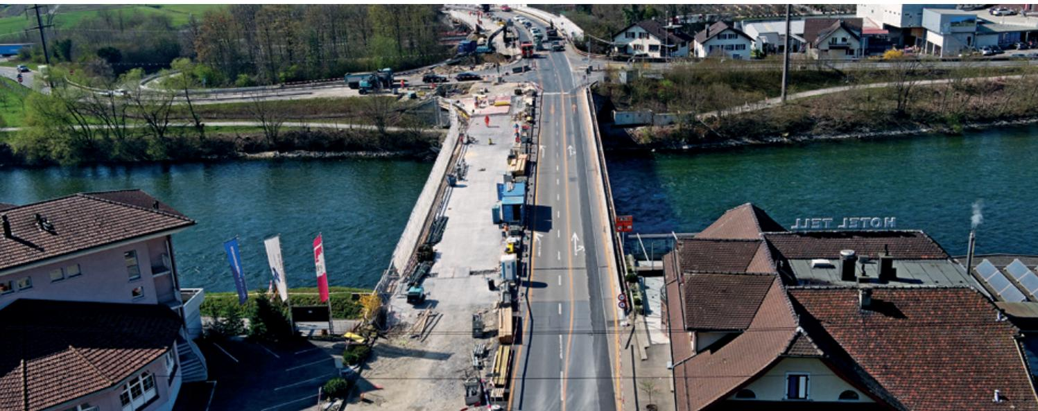
Gleichzeitig mit den Arbeiten auf der Brücke über die Reuss und der Überführung über die Autobahn A14 (im Hintergrund) werden auch die Knotenbereiche erneuert.
