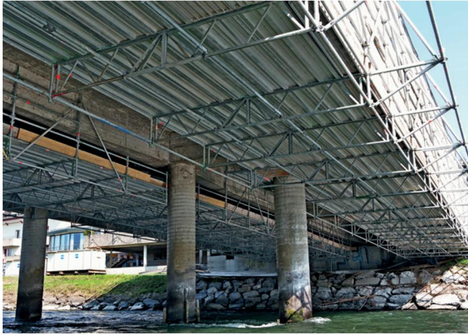
Das Baugerüst ist mit Gewindestangen an der Brücke hängend befestigt.
