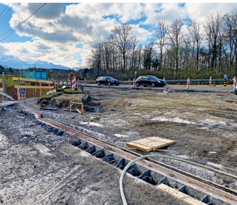
Die Fahrbahnübergänge an der Nahtstelle zwischen Brücke und gewachsenem Boden sind für den sicheren und lärmarmen Verkehr zentral.
