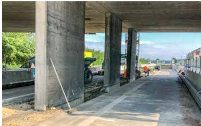
Instandsetzung der Mittelpfeiler der Autobahnbrücke
