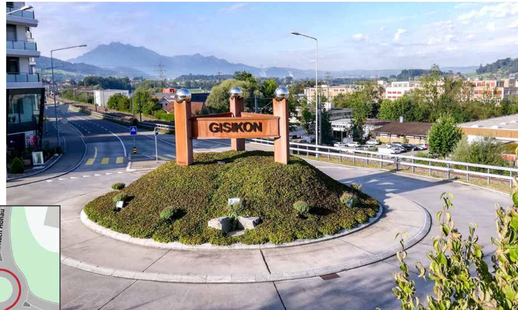
Die Zufahrt zu den Industriequartieren Tell und Reuss aus Richtung Inwil führt während den Bauarbeiten über den Kreisel Weitblick, Gisikon
