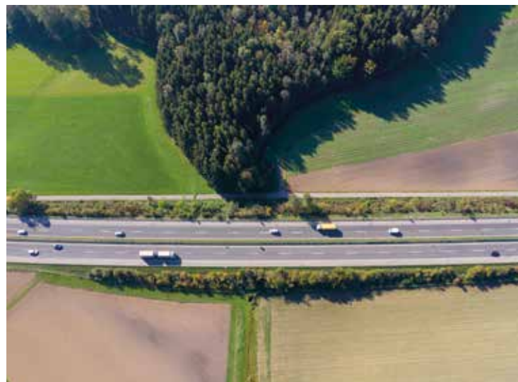
Der Standort der neuen Wildtierquerung in Knutwil und der SABA Eriswilergraben.
