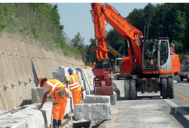
Erstellung von Blocksteinmauern am rechten Fahrbahnrand in Fahrtrichtung Zürich.
