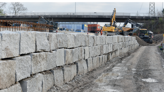
Bau einer Stützmauer zwischen der Autobahn A1 und dem parallel verlaufenden Feldweg.
