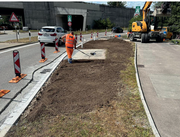
Am Anschluss Wallisellen wurde die Auffahrtsrampe Richtung St. Gallen sicherer gemacht.
