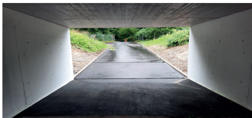
Die Fussgängerunterführung Brandholzweg wurde verlängert.
