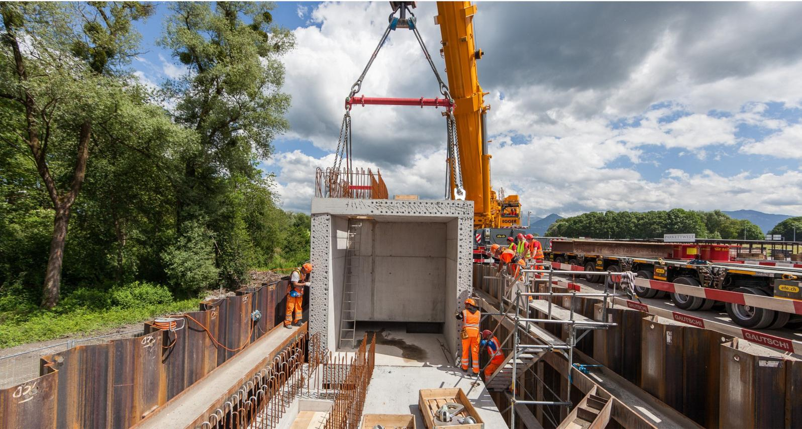
Die 19 entlang der A1 eingesetzten Havariebecken decken die Grundbehandlung des Strassenabwassers und einen Havariefall ab.
