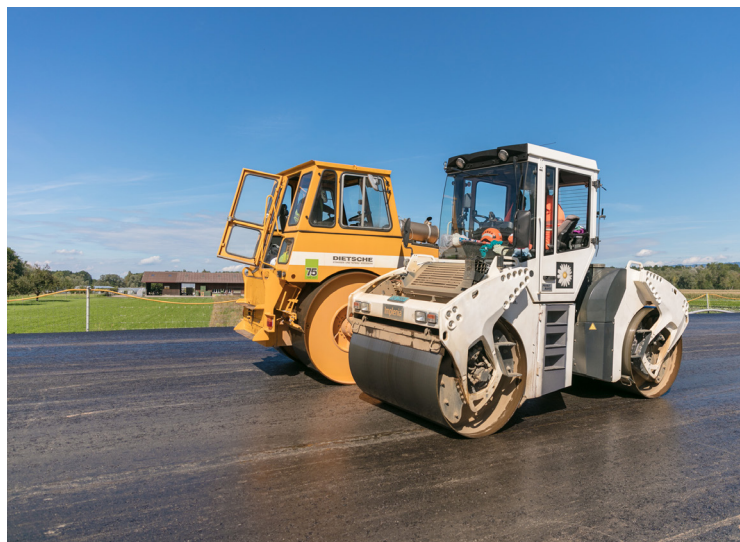
Der neu gegossene Asphalt aus Recyclingmaterialien wird gewalzt.
