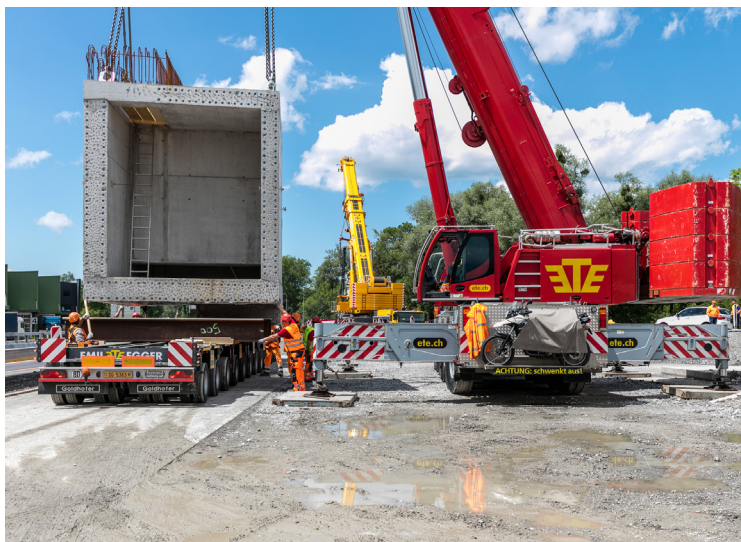
Ein Havariebecken wird entlang des Autobahnabschnitts eingebaut.
