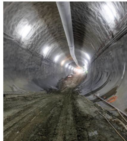
Aktuell ist der Tunnel rund 350 Meter tief.
