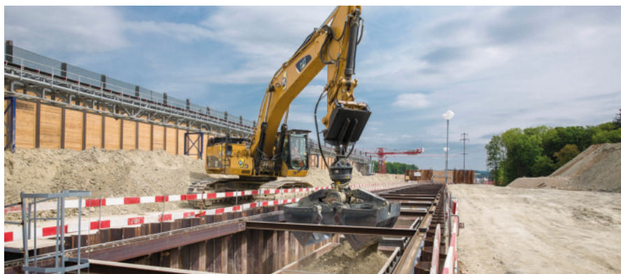
Ein Güterzug wird im Verladebahnhof mit Ausbruchmaterial beladen.
