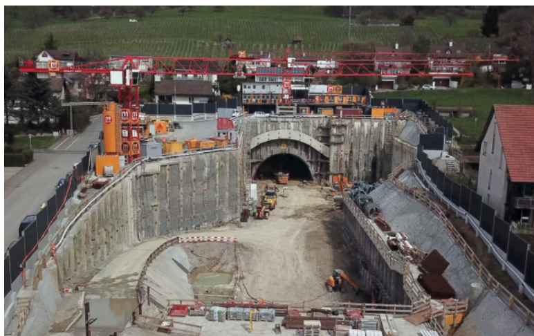
Baugrube Tagbau Weiningen mit dem rund 50 Meter tiefen Tunnel.
