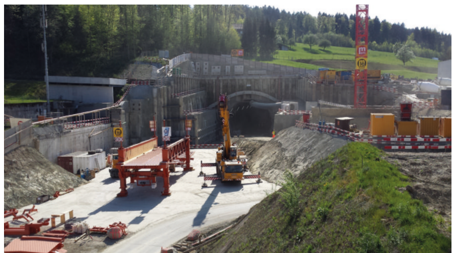
Seit dem November 2017 sind die Arbeiten beim Tunnelportal in Affoltern in vollem Gang.
