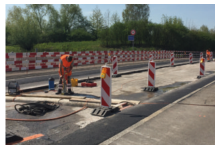
Belagsarbeiten auf der Überführung.
