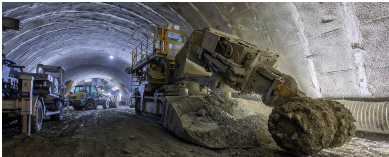
Die Teilschnittmaschine (TSM) schrämt mit einer Walze die Tunnelbrust ab.
