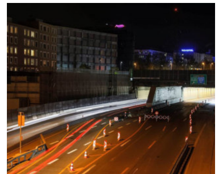
Der Stelzentunnel ist bald fertig saniert.
