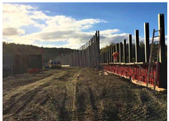
Der temporäre Verladebahnhof in Regensdorf wird erstellt.
