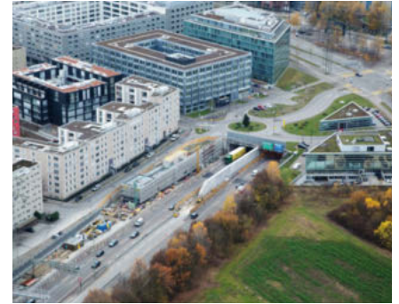
Der Stelzentunnel wird umfassend erneuert.
