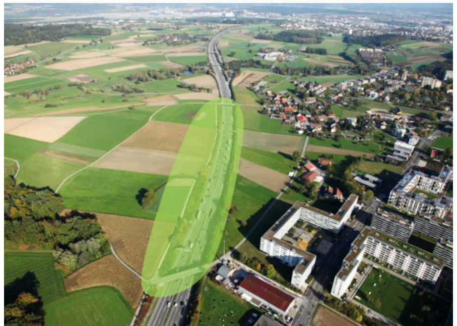
Durch die Überdeckung Katzensee wächst die Landschaft wieder zusammen.
