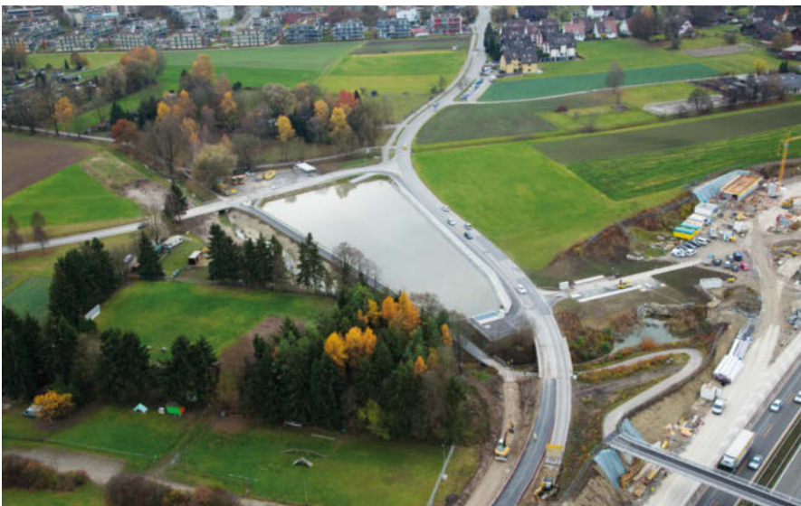
Die Anlage Grütwisen ist bereits fertig gebaut.
