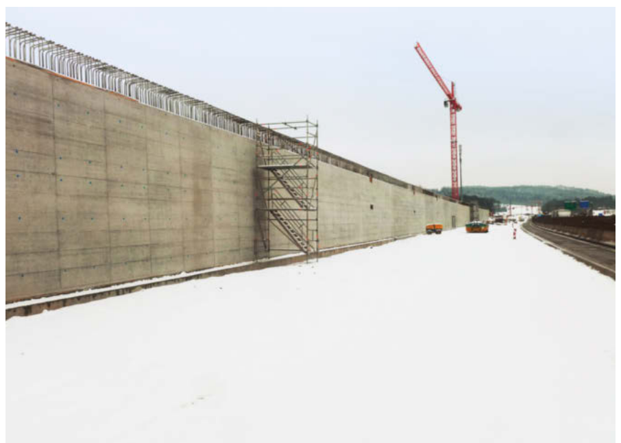
Die «Tunnelwand Süd» ist im Bau (von der Autobahn her aufgenommen, Stand Januar 2017).
